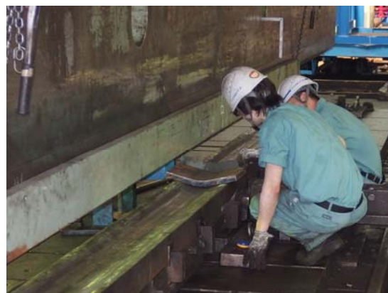
b) 冷間曲げ加工の施工後
