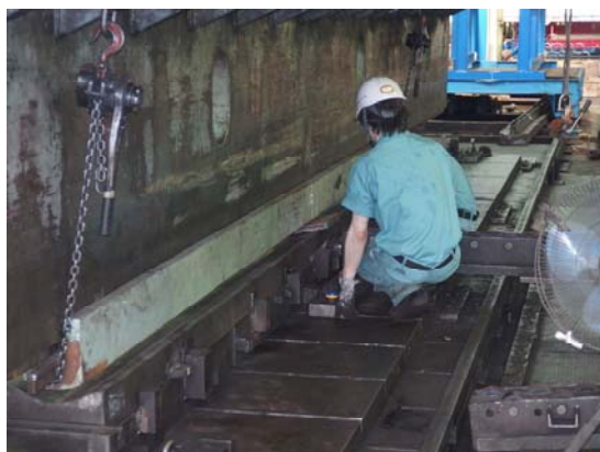
a) 冷間曲げ加工の施工中
