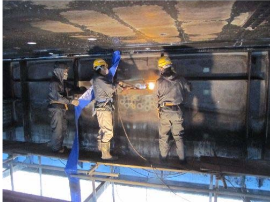
主桁ウェブの加熱矯正状況
