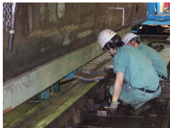
b) 冷間曲げ加工の施工後
