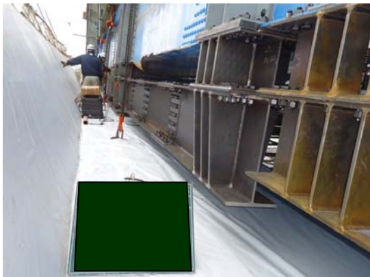
バイパス部材設置状況
