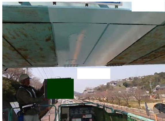
補修完了状況
