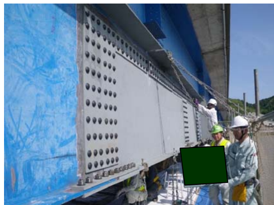
材片の取替完了状況
