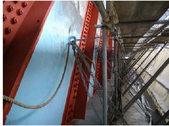
主桁ウェブの補強材設置完了状況
