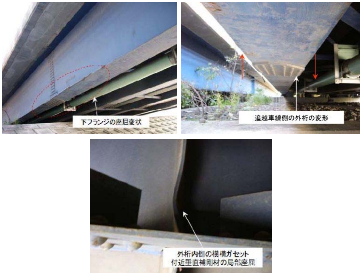
写真-4.1.1 損傷状況
