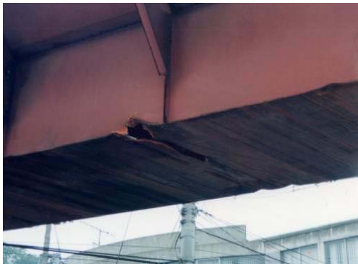
損傷状況（外面）
