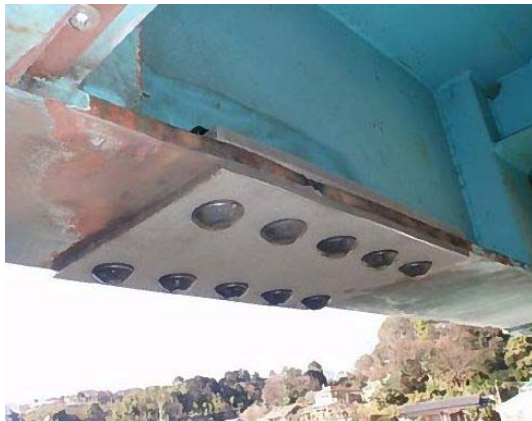
加熱矯正後（当て板施工後）
