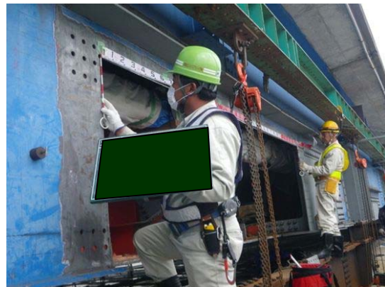
損傷部の切断・撤去状況
