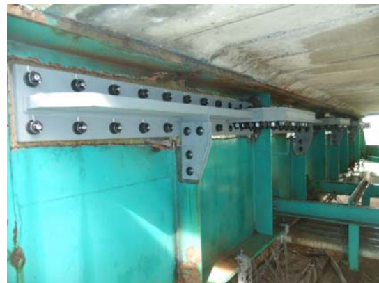
補強材片の設置状況
