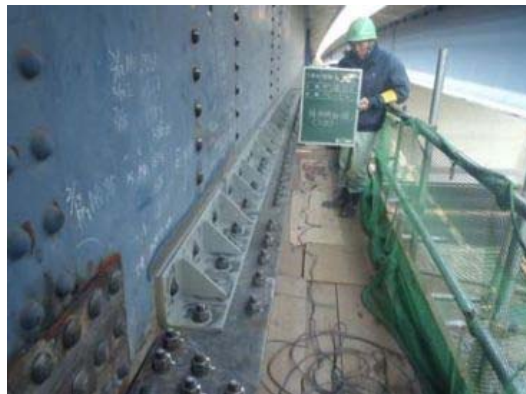
当て板設置完了状況
