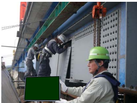
材片の取替作業状況
