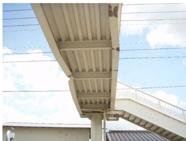
参-写真-2.2.1 主桁の面外変形
