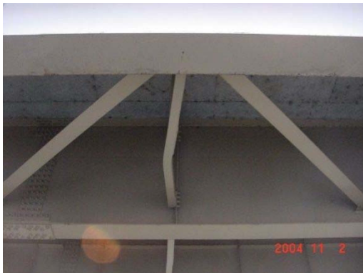
鋳桁の中間対傾構
