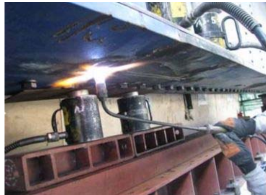
下フランジ下面加熱矯正状況
