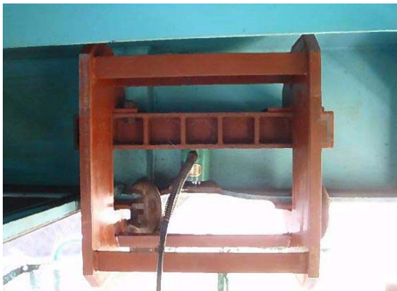
加熱矯正（ジャッキによる加圧）
