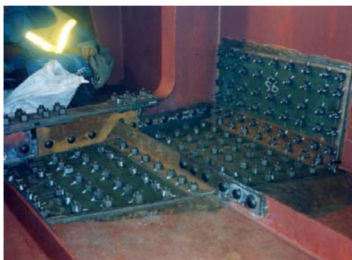
材片の取替完了状況
