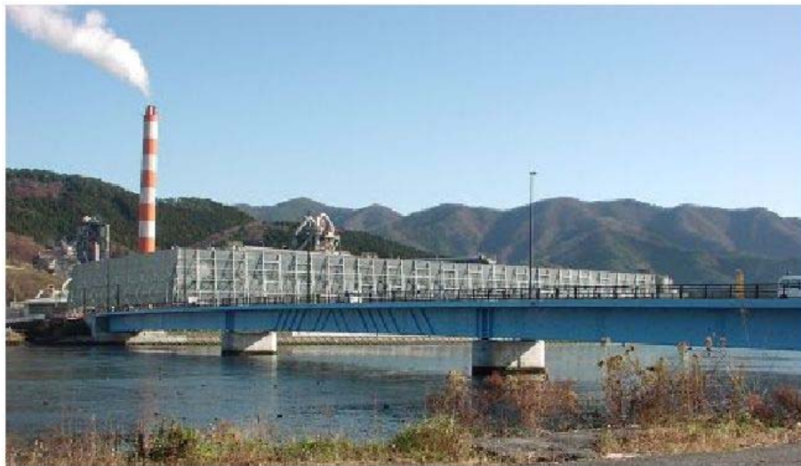
写真-4.2.3 補修完了後の全景
