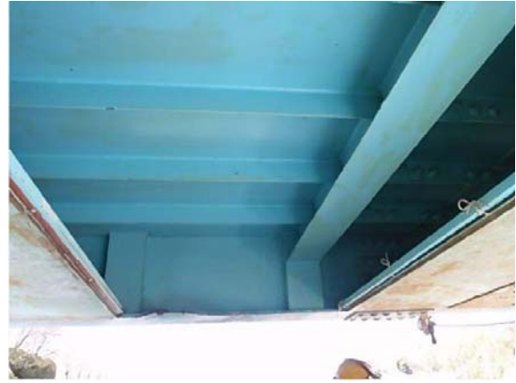
損傷状況（化粧パネル撤去）
