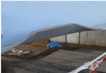
参-写真-2.1.2 損傷部の写真
