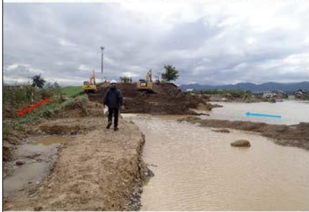
写真5 千曲川左岸5.8k p付近に形成された落堀
