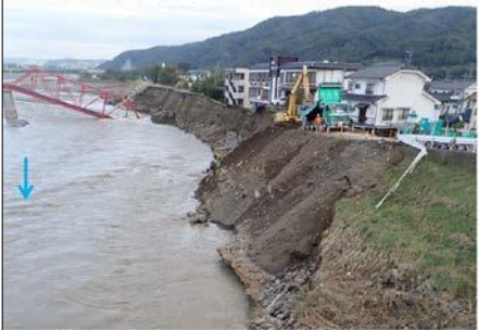
写真6 千曲川左岸1.04k p付近の堤防欠損箇所
