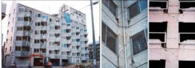
倒壊は免れ人命を守ったが、柱・はり・柱はり接合部の損傷が極めて大きく、その修復費用が莫大であったため取り壊され建て直された
