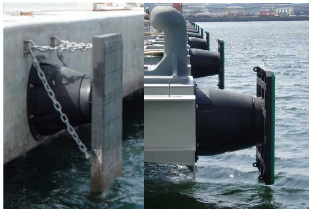
図-2.2 円錐型防舷材(受衝板付)の例（同左）
