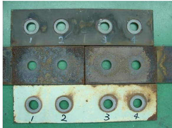
写真 5. 3. 7 主材と添接板の腐食状況
