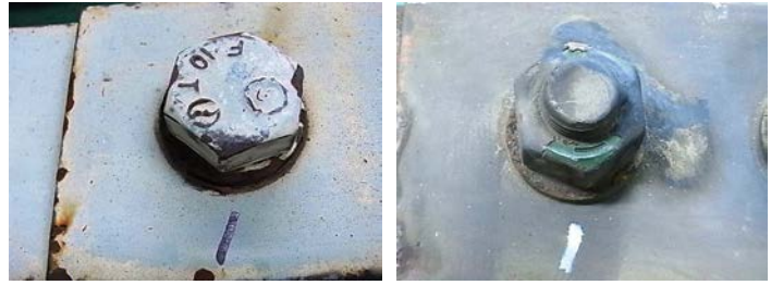
写真 5.3.2 暴露ボルトの外観 (左: ボルト頭部, 右: ナット部)
