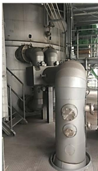
図7-2 局所攪拌空気吹込み設備の設置検討例(150wet-t/日炉例)
