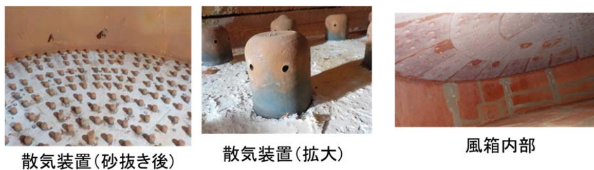
図資 1.3.3-3 炉内点検状況(清掃後 異常無し)
