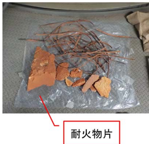
図資 1.3.6-3 流速調整用格子板回収物
