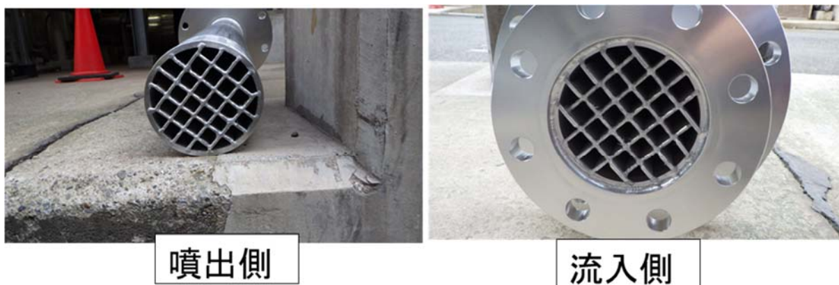
図資 1.3.6-4 流速調整用格子板(対策品)
