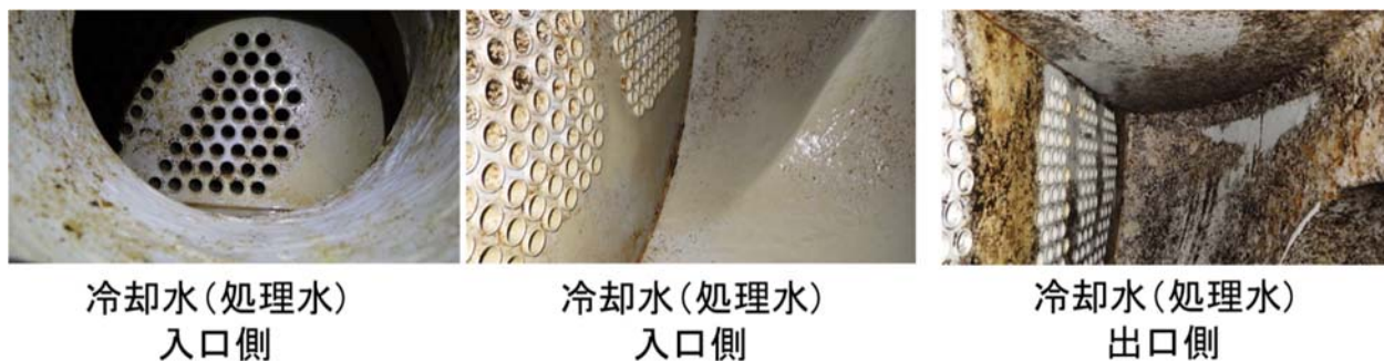
図資 1.3.2-1 復水器冷却水側の状況
