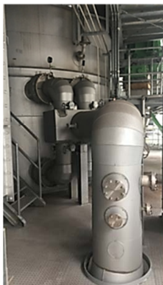
設備設置状況
