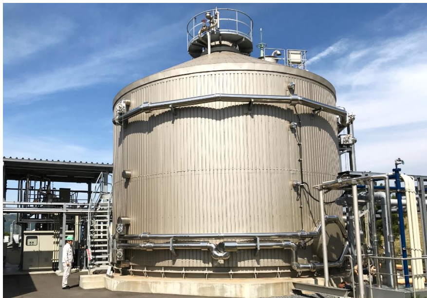
図 2-3 実証設備の無動力攪拌式消化槽
