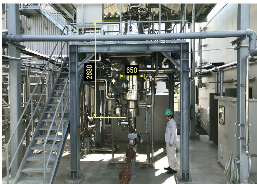
図 2-7 実証設備の高効率加熱設備(熱可溶化タンク)
