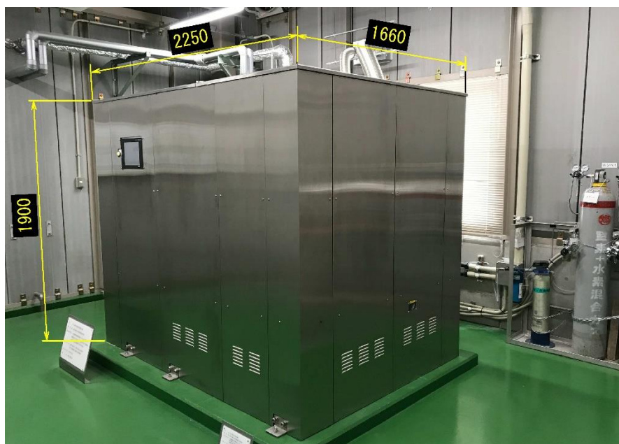
図 2-10 実証設備の SOFC のシステム機
