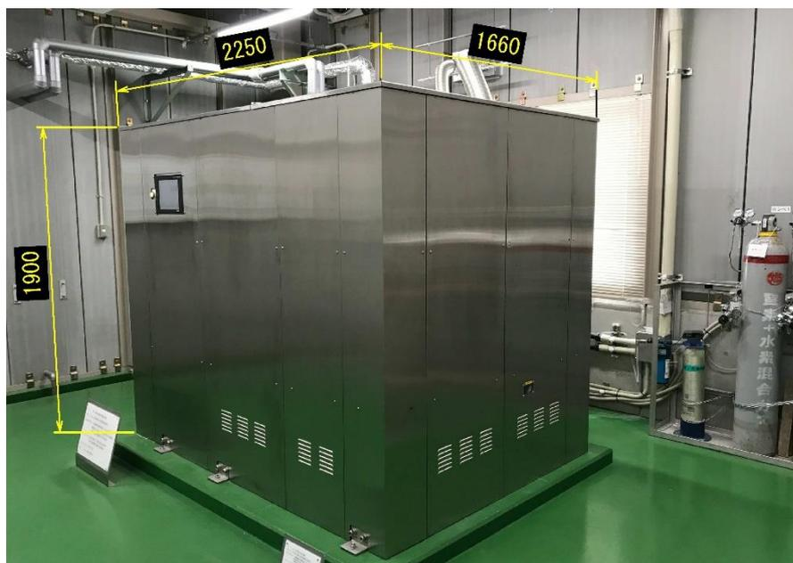
図 2-10 実証設備の SOFC のシステム機
