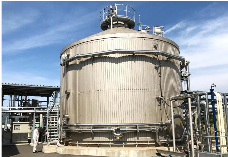
図 2-3 実証設備の無動力攪拌式消化槽
