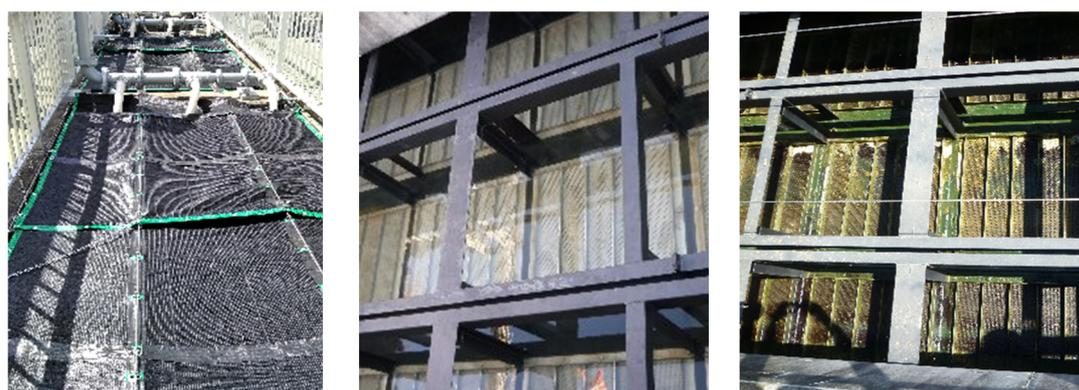
図資 1-26 ろ過部カセットでの藻の付着および生育状況
