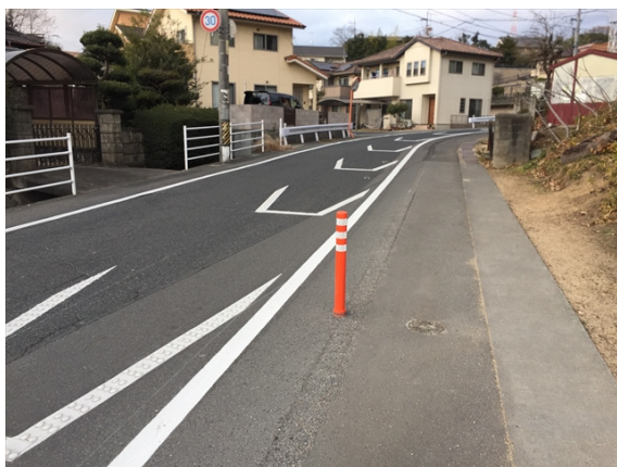
路面表示(凹型減速マーク:リブ式)
