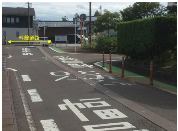
入口部での狭さく設置
