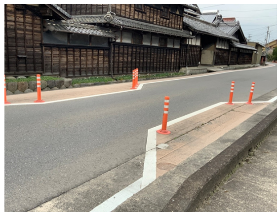
ゴム製ポールの一部撤去
