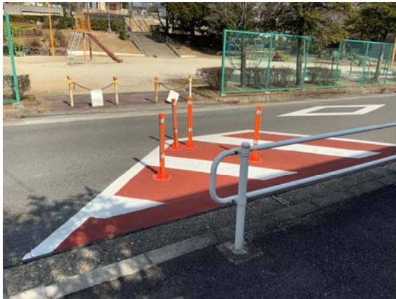
ゴム製ポールの配置
