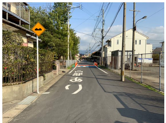
路面表示、警戒標識
