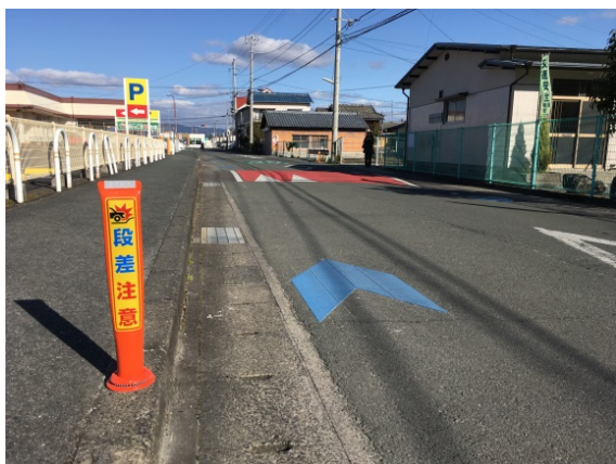
ゴム製ポールと路面表示
