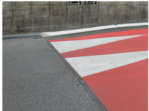
切削なしで擦り付け(オーバーレイ)
