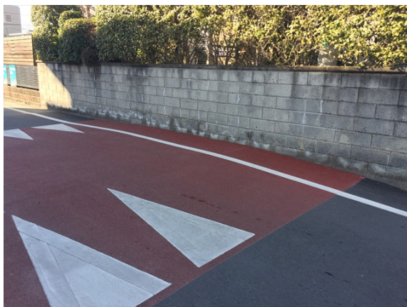
側溝上も併せて盛り上げ
