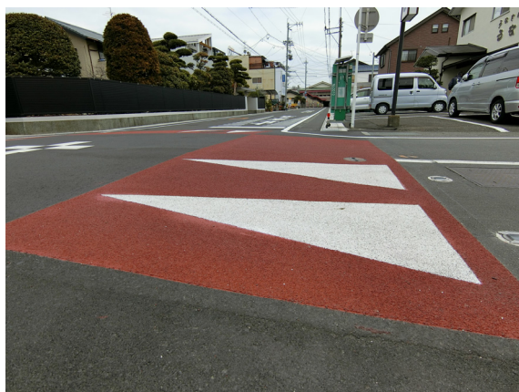
擦り付け勾配はサイン曲線を目指し施工
