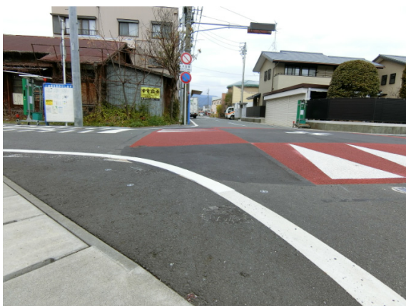
コーナーを扇形で施工(平均勾配 5%)
