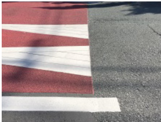
切削なしで擦り付け(オーバーレイ)
