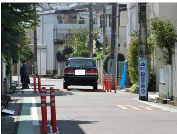
ハンプと狭さくの連続設置
