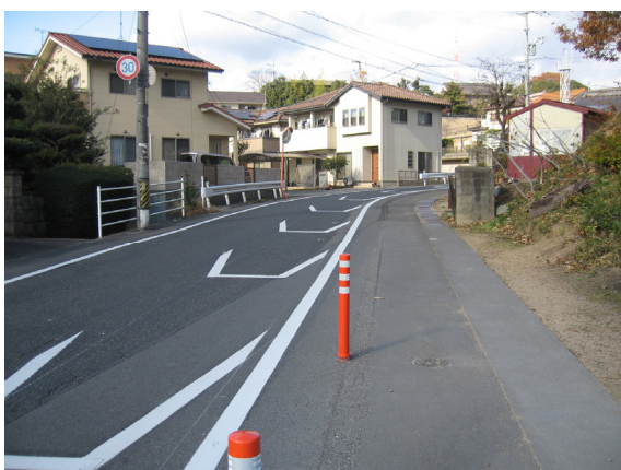
路面表示(凹型減速マーク:非リブ式) 写真提供:福山市
