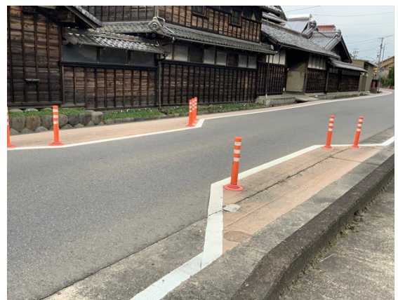
ゴム製ポールの一部撤去
