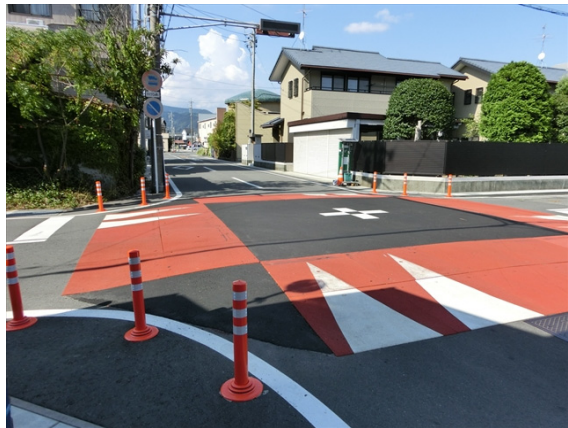
平坦部はアスファルト、傾斜部はゴム製
