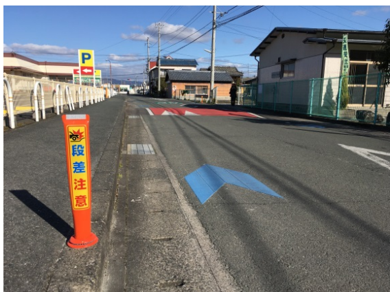
ゴム製ポールと路面表示
