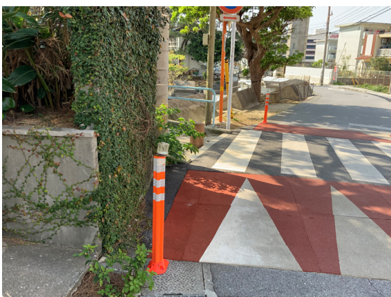
ゴム製ポール及び自発光灯
