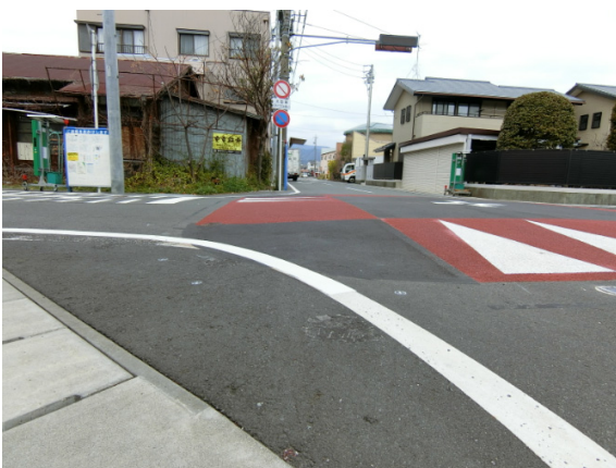
コーナーを扇形で施工(平均勾配 5%)
