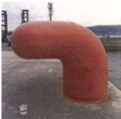
写真-3.4 神戸港の係船曲柱
