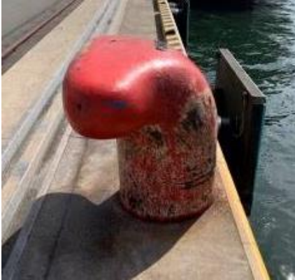
写真-3.3 大阪港夢洲の係船曲柱
