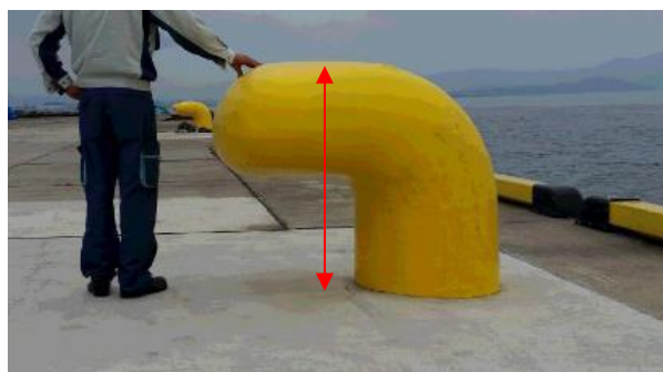
写真-1.1 2000kN型の大型係船曲柱 1)
