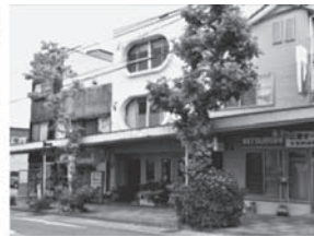
アーケード設置
