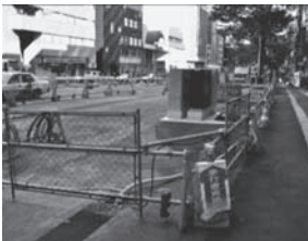
共同溝の設置
