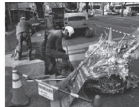
道路施設の設置
