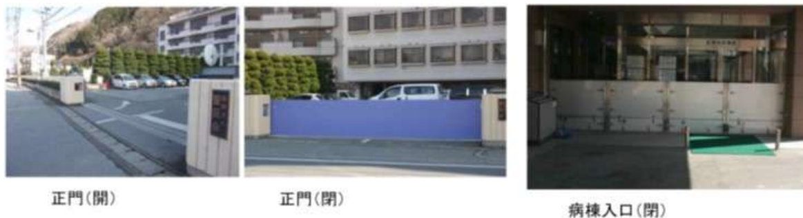
写真 5.2.5 佐用中央病院における耐水化対策 (出典:兵庫県資料)
