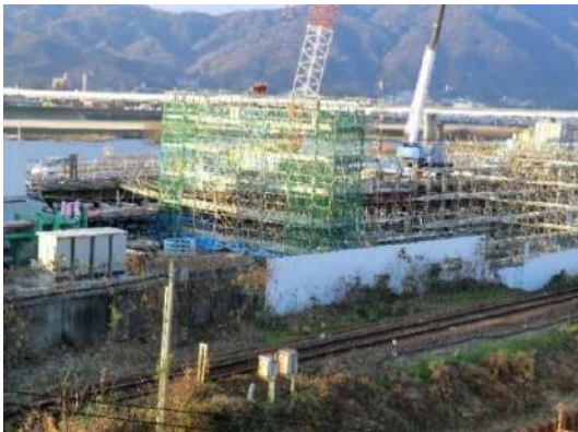
写真 5.2.15 建設中の新規排水機場 (2016年1月7日撮影)
