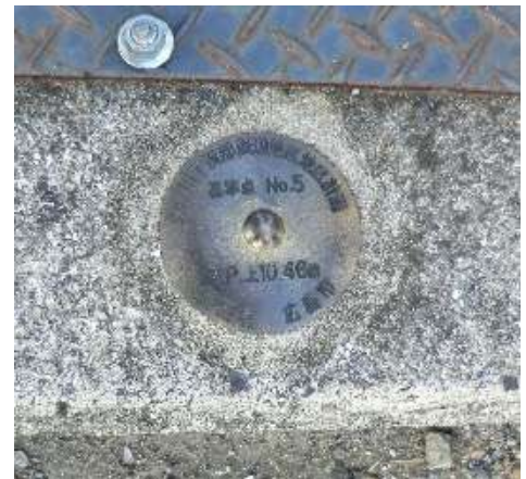
写真 5.2.11 標高の確認のために設置された基準点
