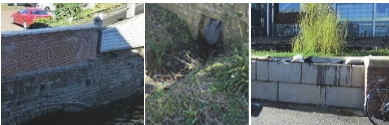
写真 5. 2. 21 BIDにより整備された洪水防御施設 (逆流防止弁及び堤防)
