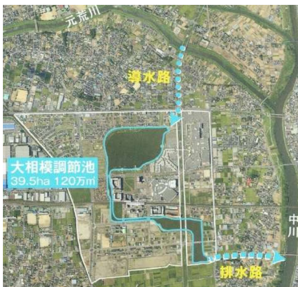
写真 5.2.8 大相模調節池と導水路・排水路 （出典：独立行政法人都市再生機構資料）
