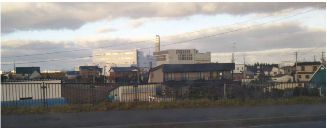
写真 5. 2. 4 災害危険区域の指定区域の概況
