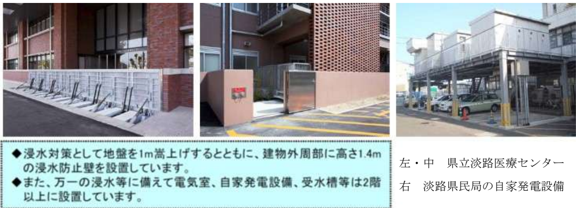
写真 5. 2. 6 県施設における耐水化対策の事例 （出典：淡路(三原川等)地域総合治水推進計画）
