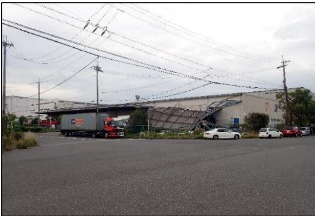
写真 5-5 上屋への被害 (堺泉北港)
