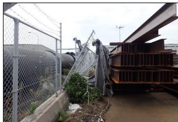
写真 5-4 フェンス倒壊（阪南港）
