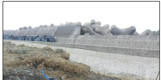
写真 5-13 越波による堤体の破断 (和歌山下津港)
