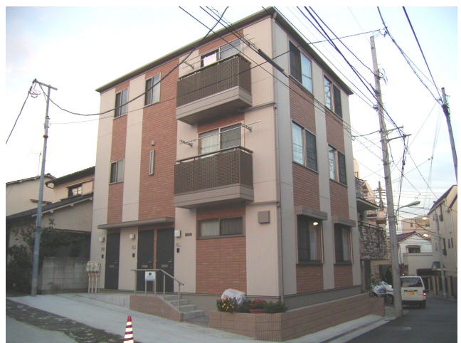
道路斜線や前面道路幅員による容積率の制限を緩和して、総3階の建物を建てました
