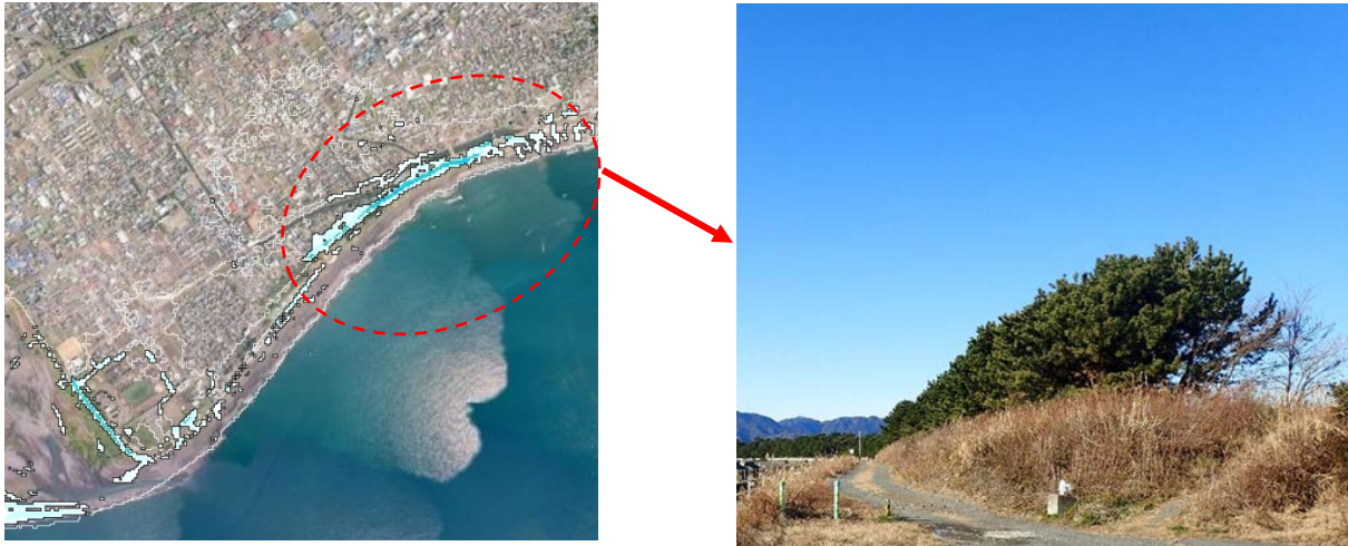
図-2.2.14 津波水位の傾斜角図（左）と、同図から抽出された盛土構造物（右）の例 （「南海トラフ巨大地震モデル検討会」の公開データをもとに作成、 左の空中写真は地理院地図から引用。表示色は表-2.2.2 参照）
