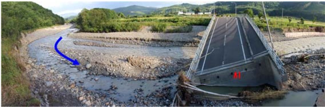
写真-3. 2. 3 A1 橋台の状況（再掲）
