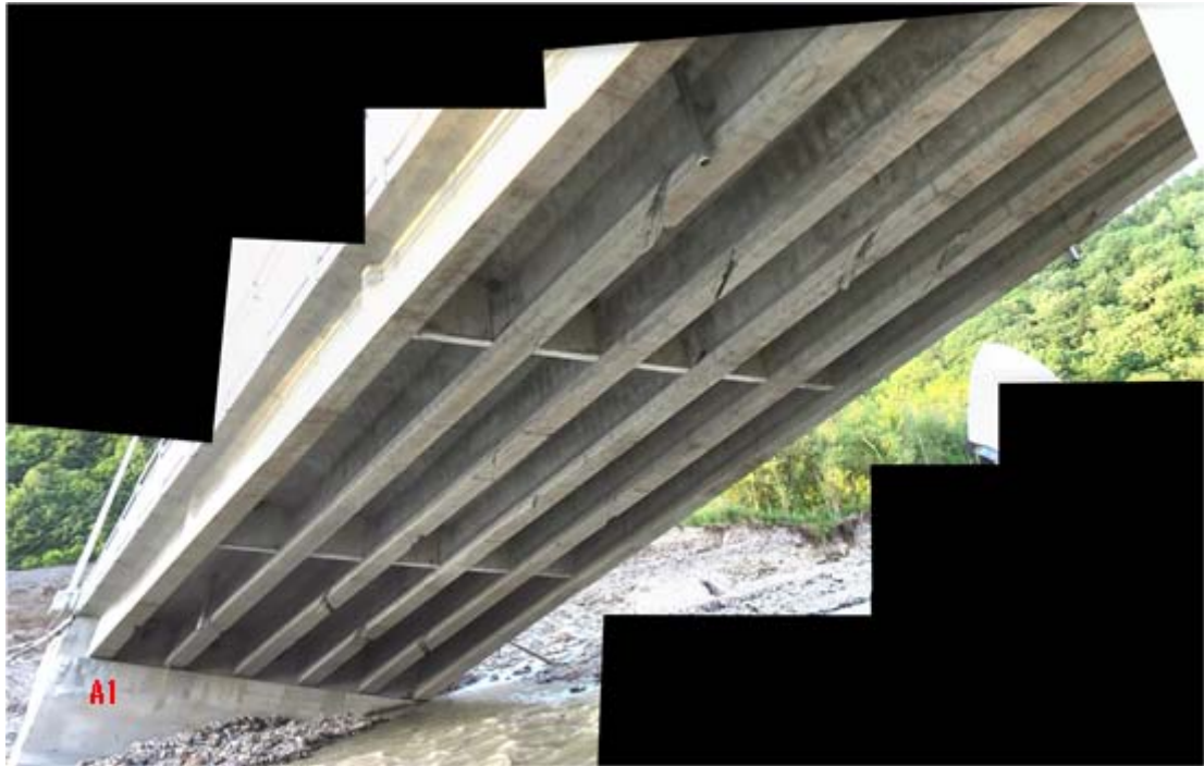
写真-3. 2. 4 第 1 径間上部構造の状況（再掲）
