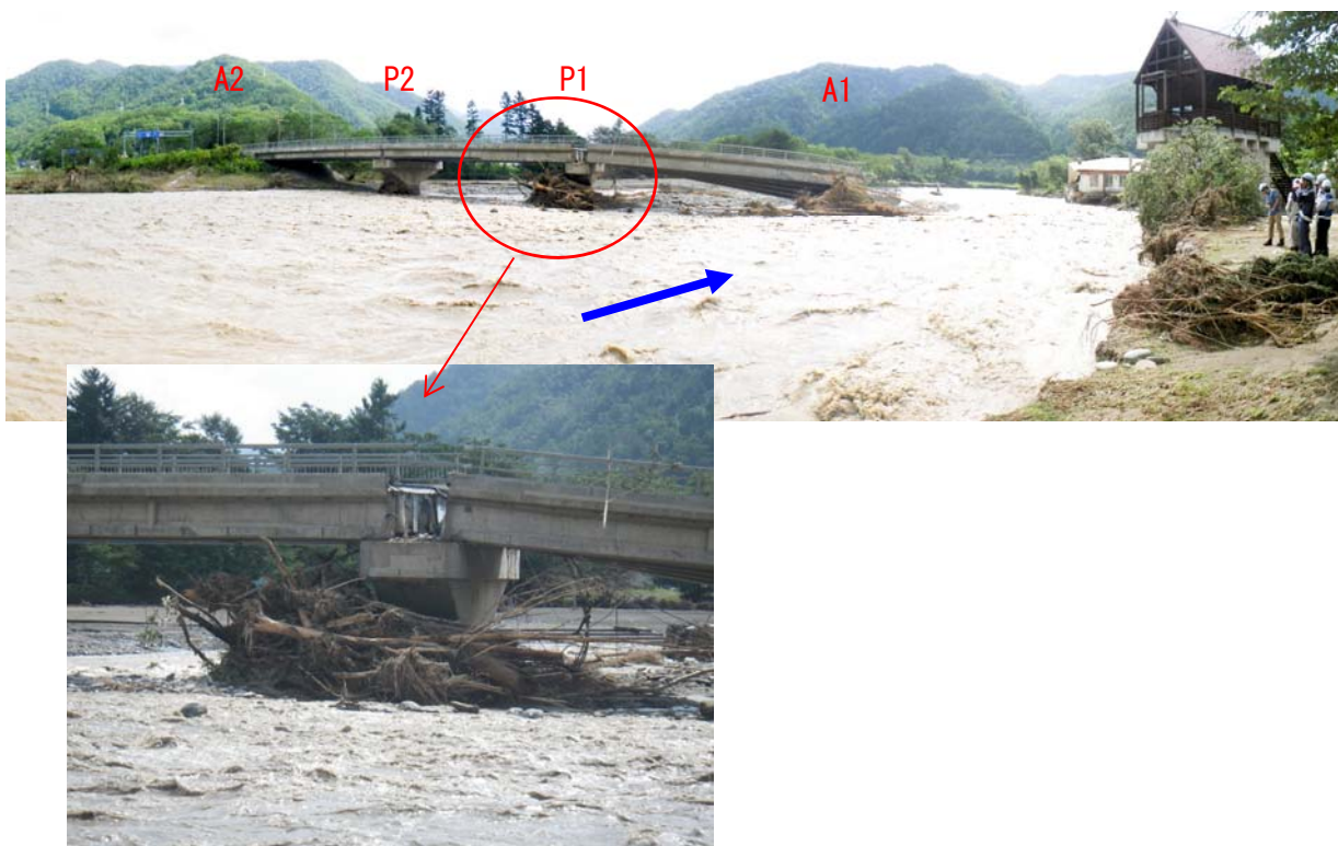
写真-3.3.2 右岸側上流側より撮影
