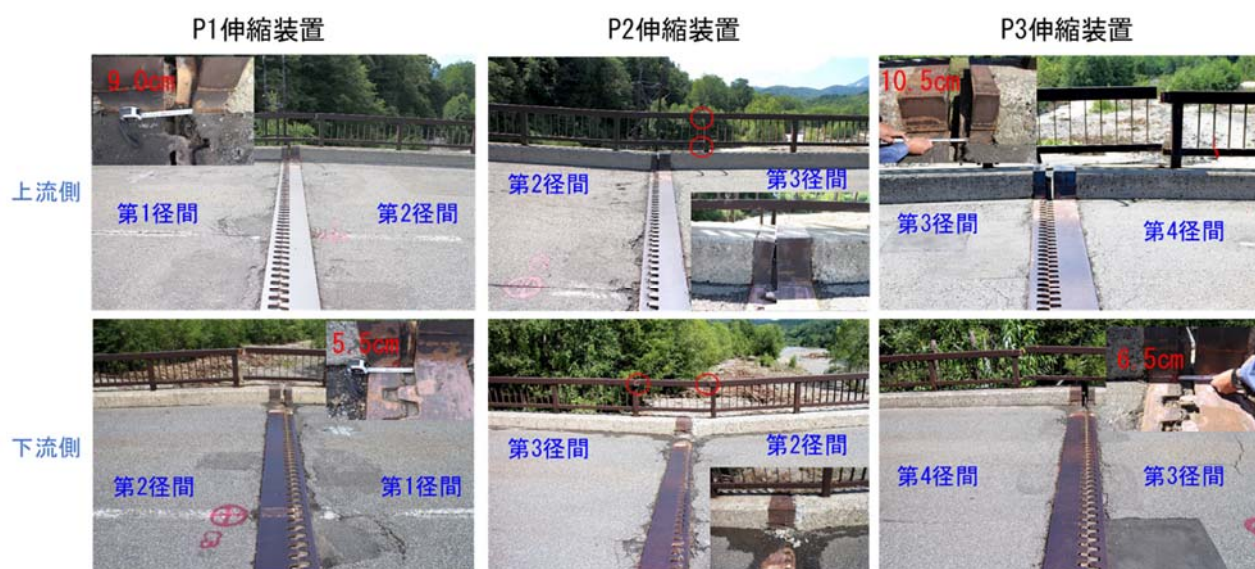
写真-3.1.9 伸縮装置の状況
