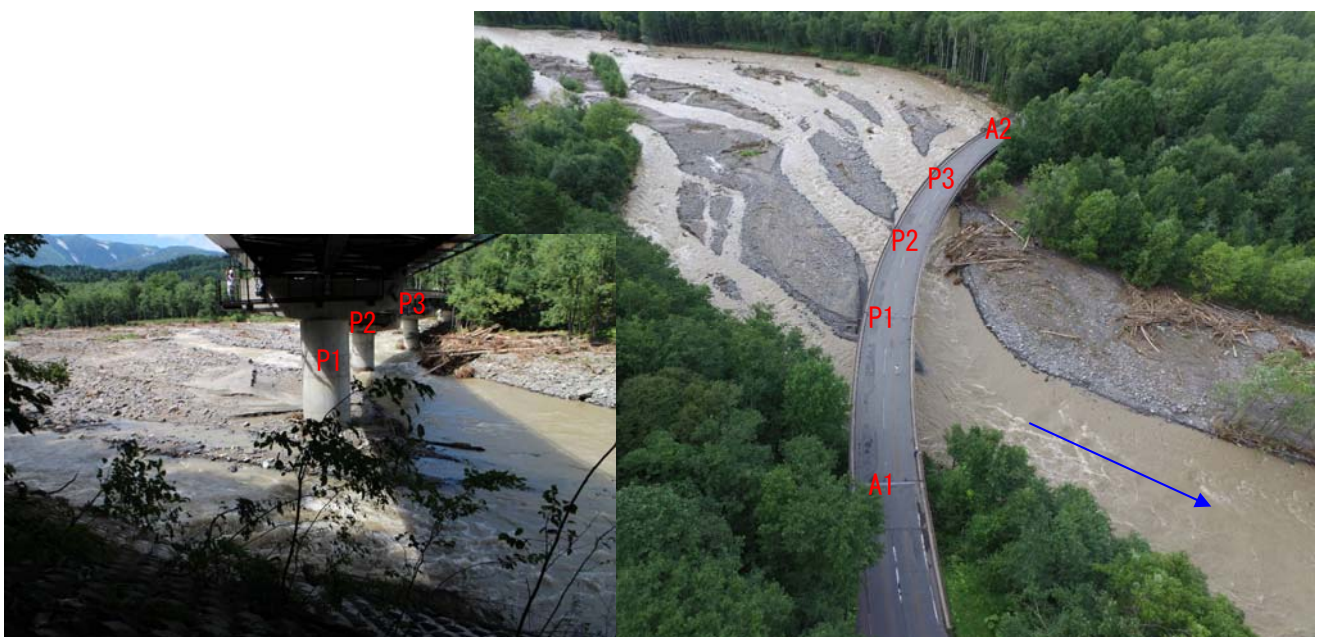
写真-3.1.13 写真(左)(A1橋台より撮影)
