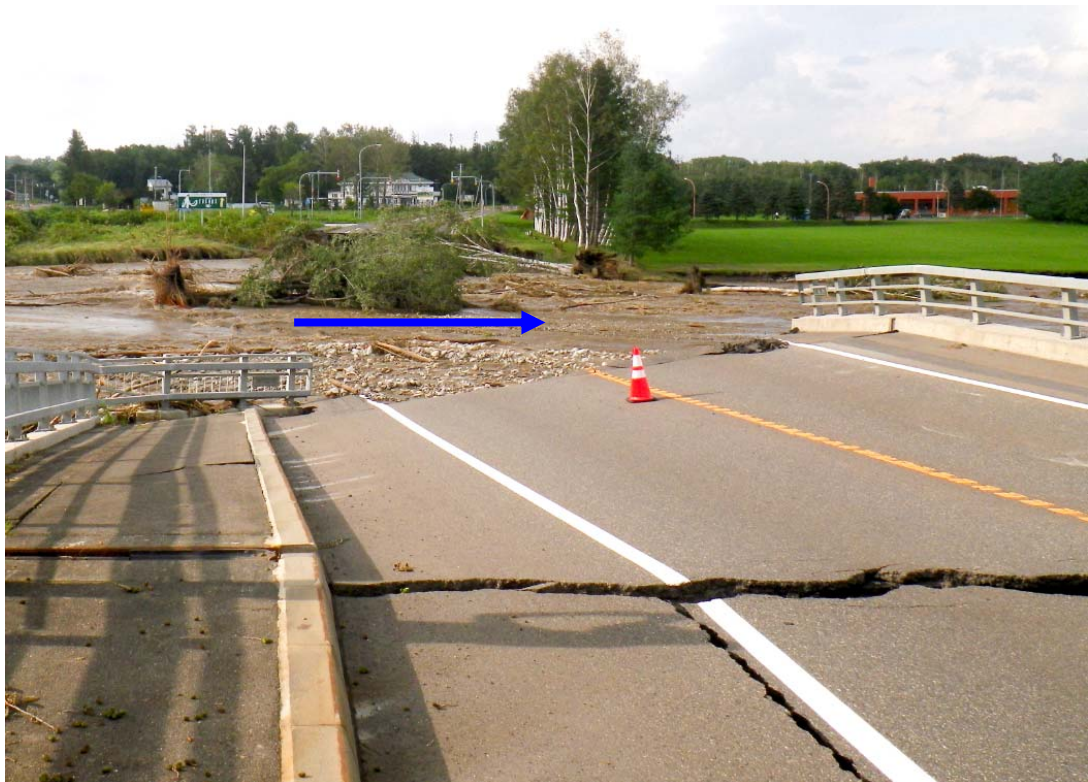
写真-3.4.2 A1 橋台背面土流失状況
