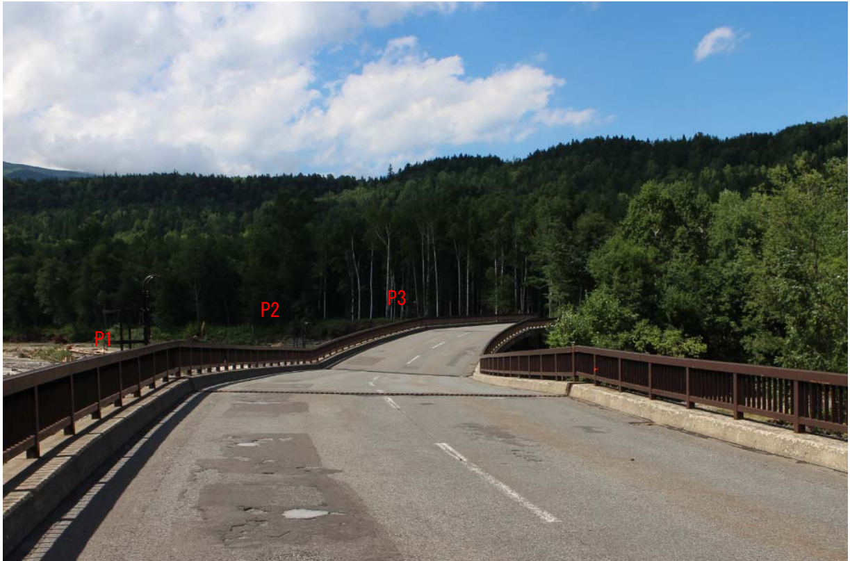
写真-3.1.1 高原大橋路面状況（A1 橋台付近から撮影）
