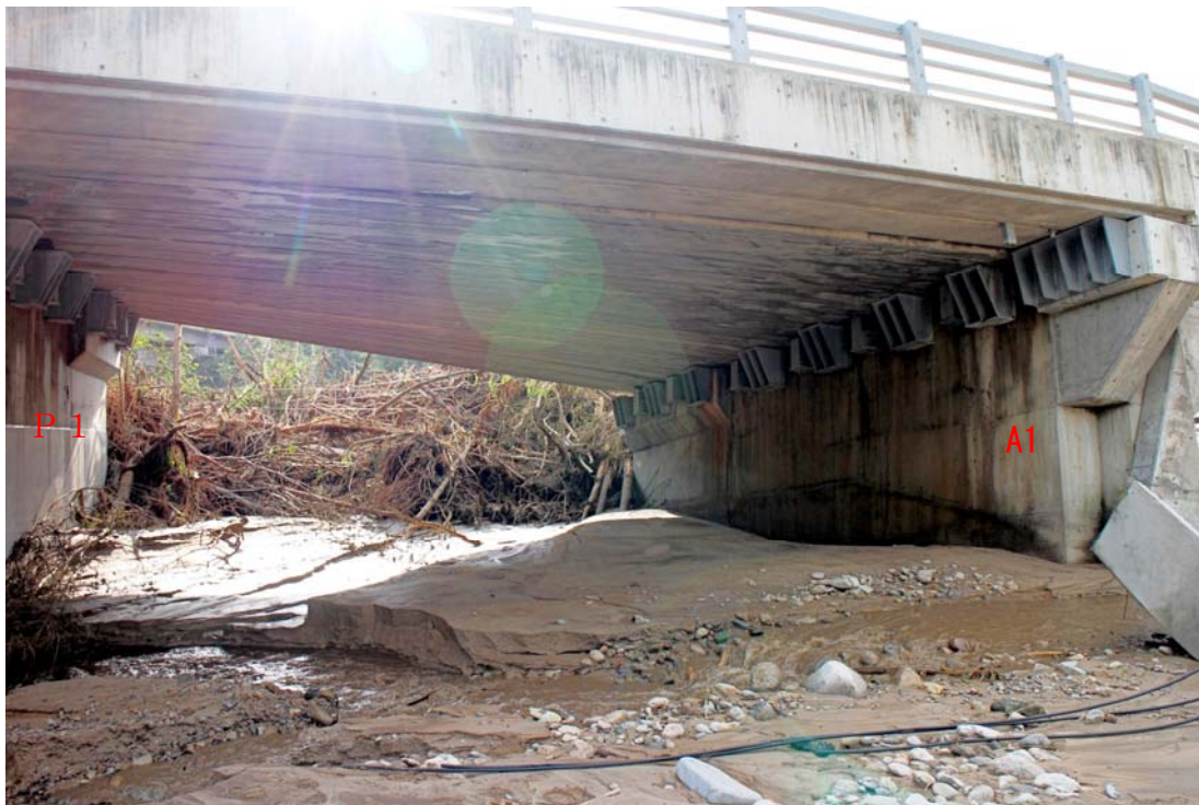
写真-3.4.5 第1径間の状況（下流側より撮影）
