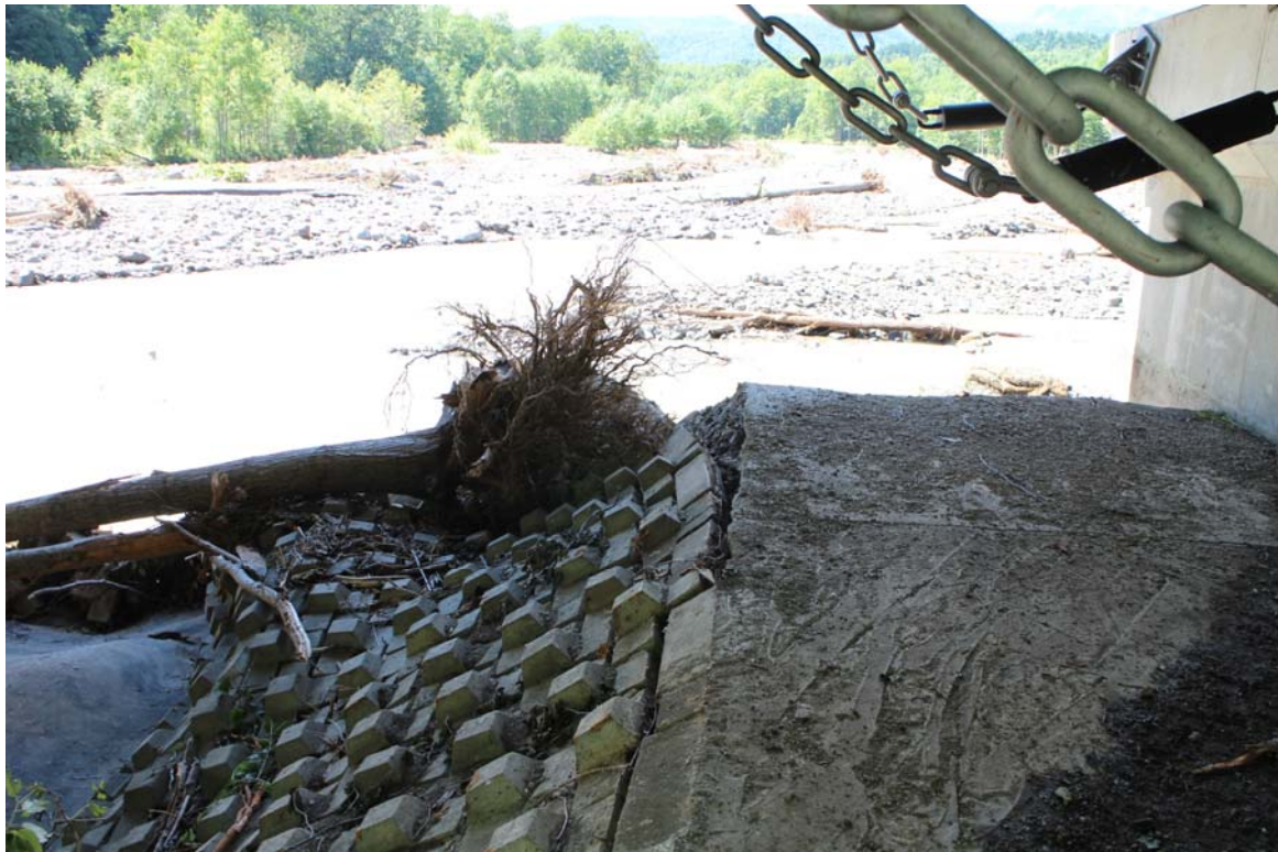
写真-3.1.6 A2 橋台前面の護岸状況
