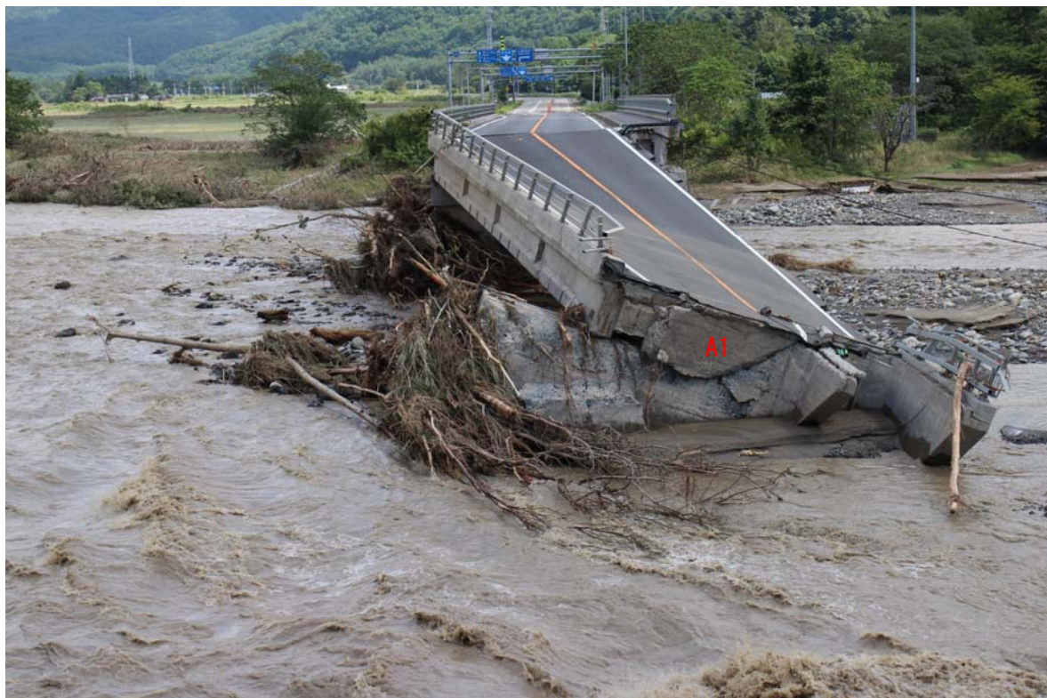
写真-3.3.4 右岸側より撮影
