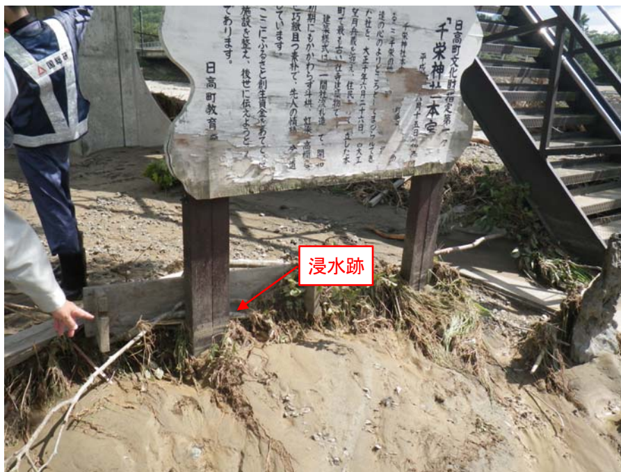
写真-3.3.6 右岸側上流側の千栄神社看板周辺の増水状況
