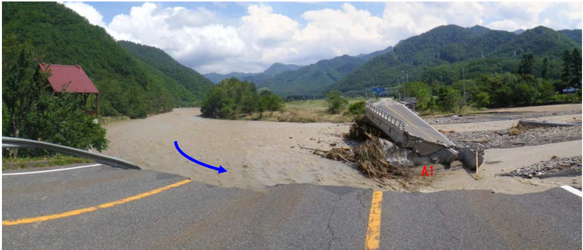
写真-3.3.3 右岸側より撮影
