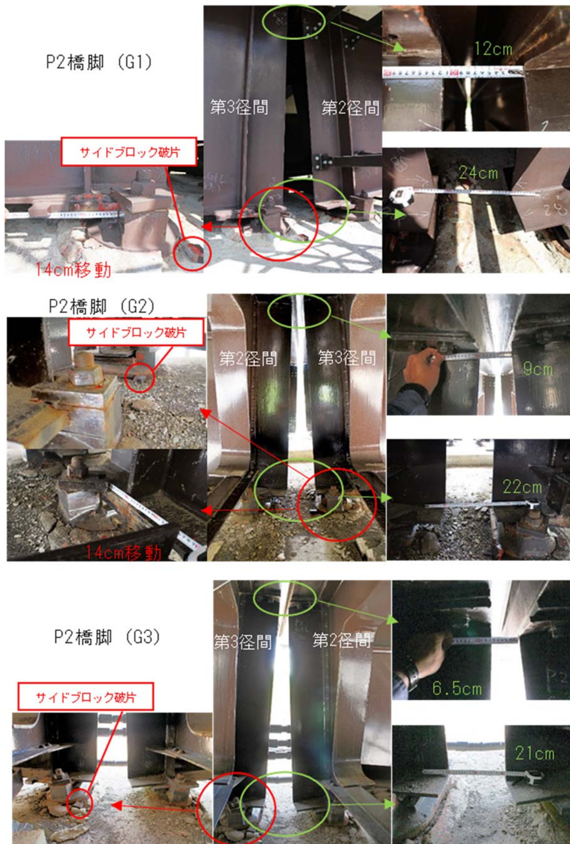
写真-3.1.10 P2 橋脚上の支承の状況
