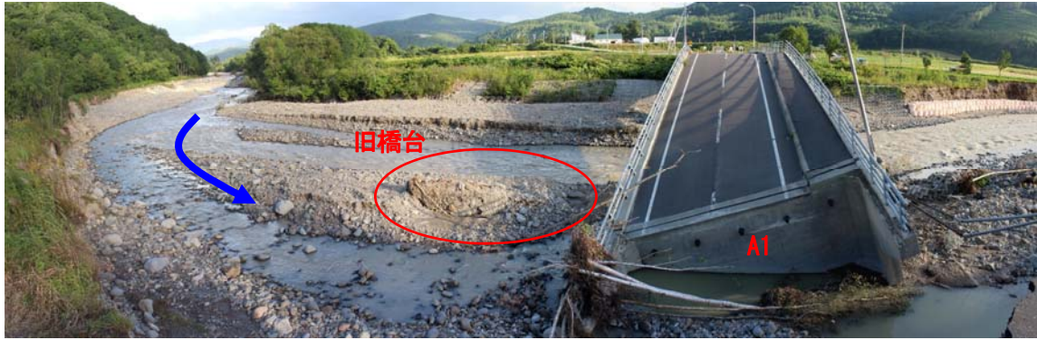
写真-3.2.3 A1 橋台の状況
