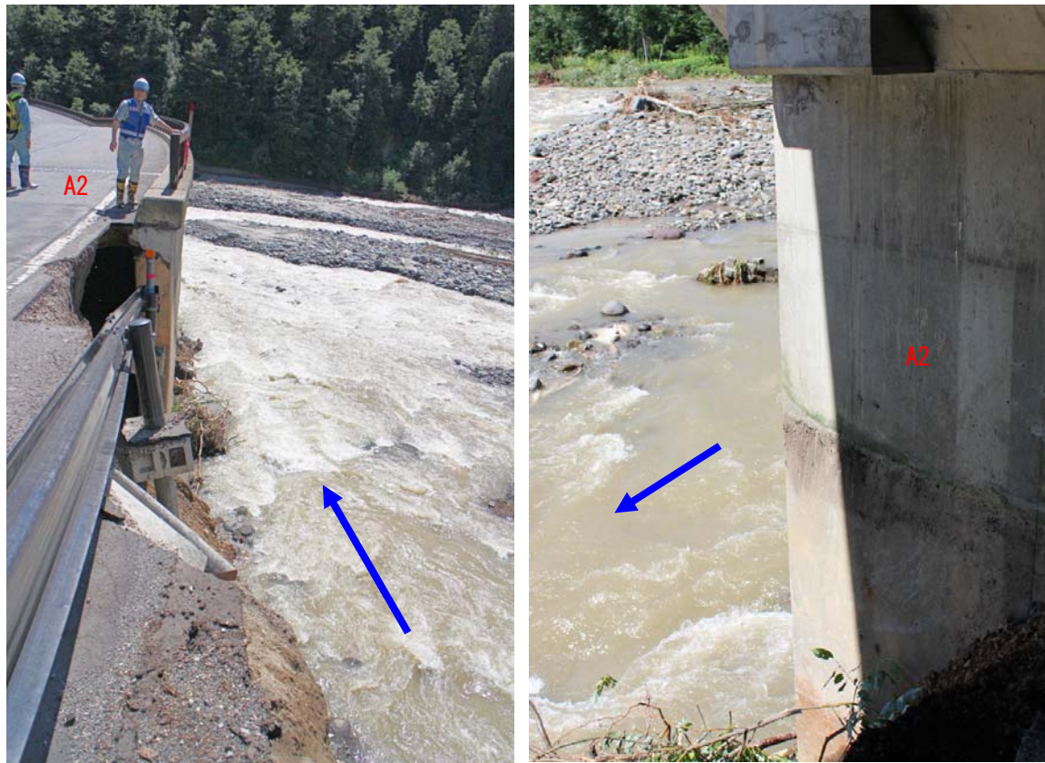
写真-3.1.4 A2 橋台背面路肩崩落状況(左)及び A2 橋台前面上流側状況 (右)
