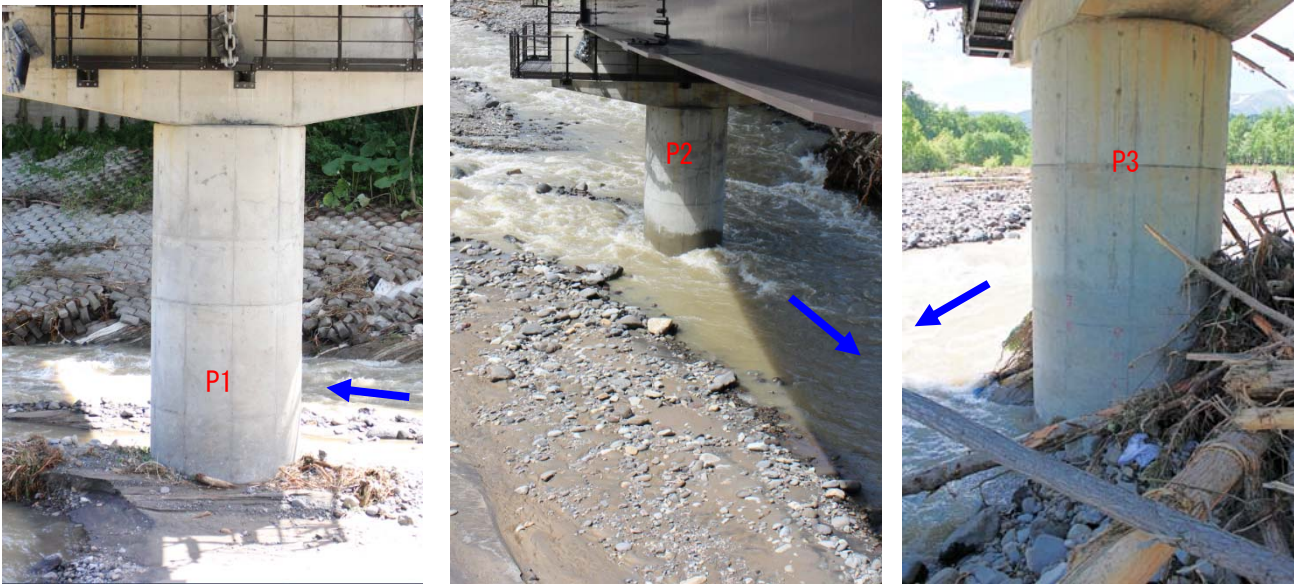
写真-3.1.8 橋脚基礎の状況
