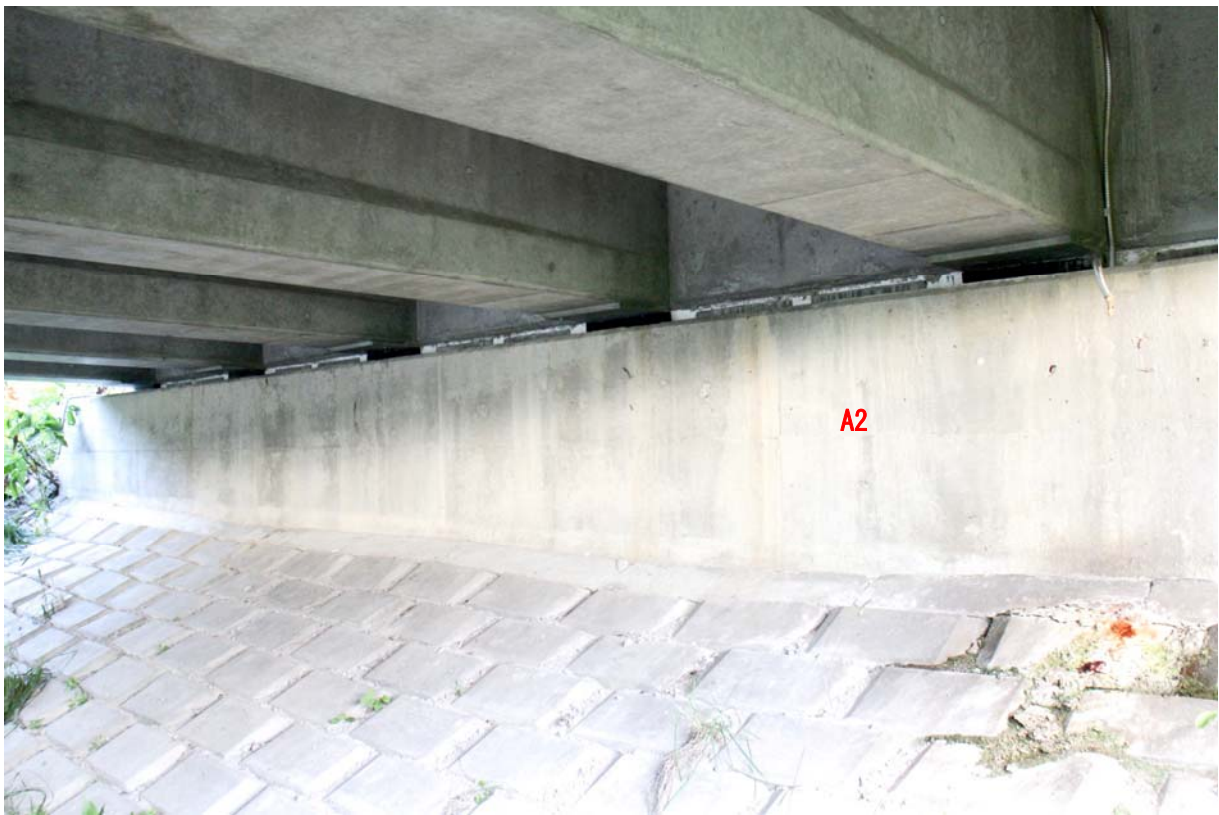
写真-3.2.9 A2 橋台の状況
