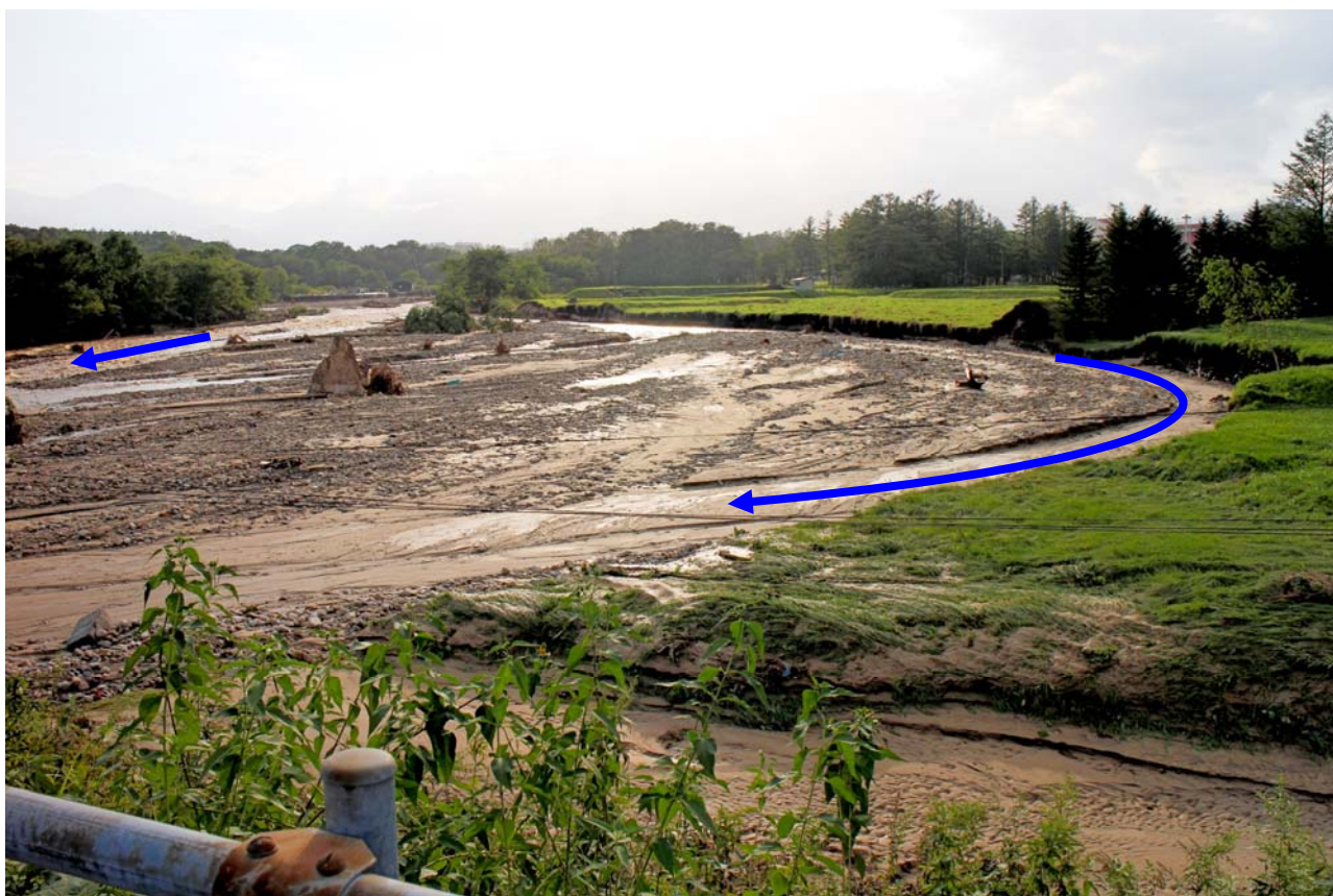
写真-3.5.5 上流側侵食状況（左岸側より撮影）
