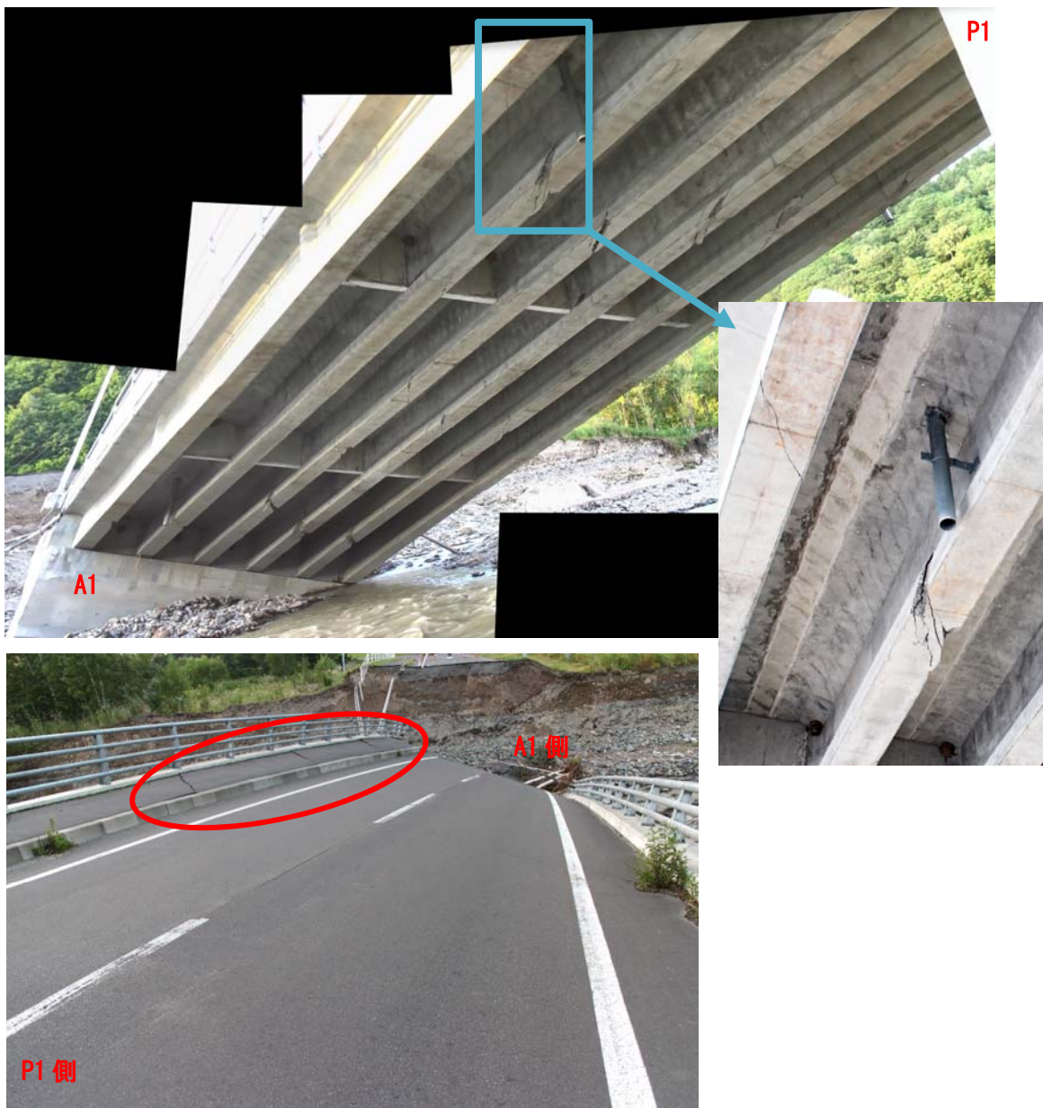
写真-3.2.4 第1径間上部構造の状況
