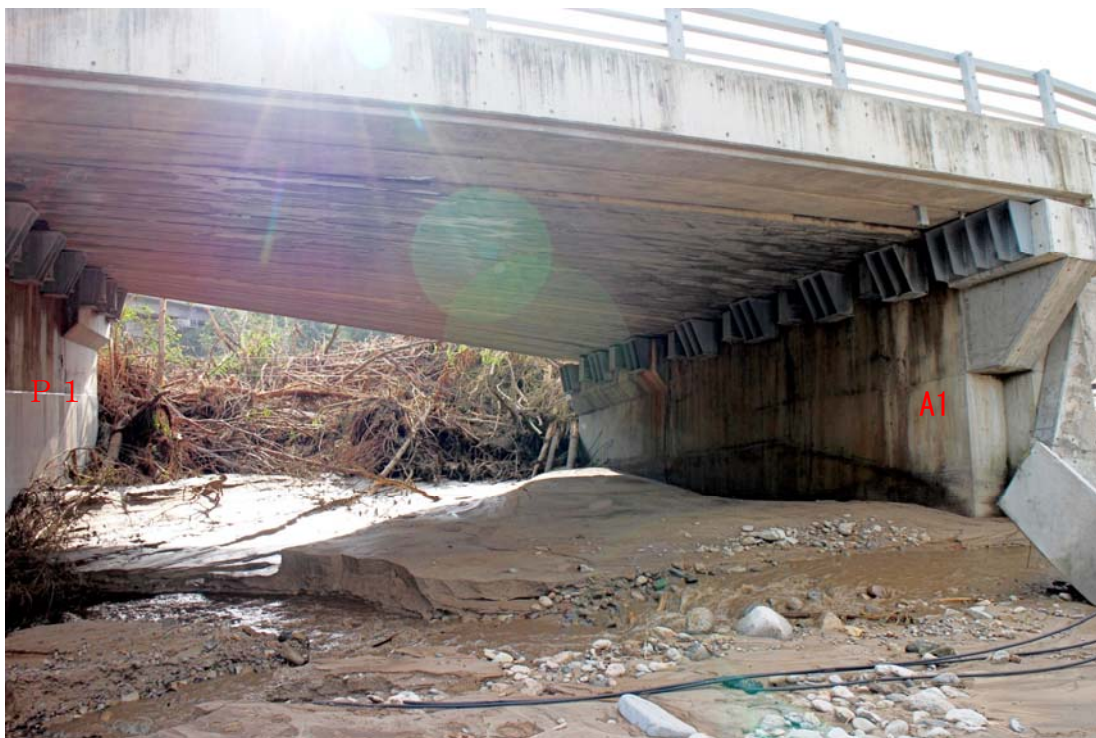
写真-3.4.5 第1径間の状況（下流側より撮影）
