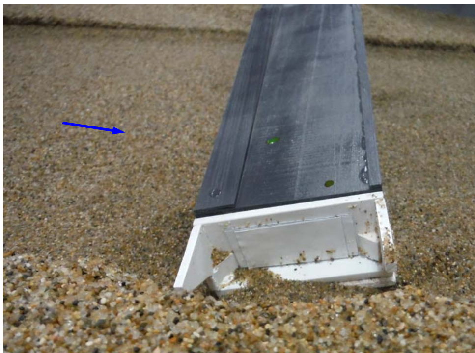
写真-4. 2. 2. 3 通水後の状況（右岸より左岸方向を臨む）
