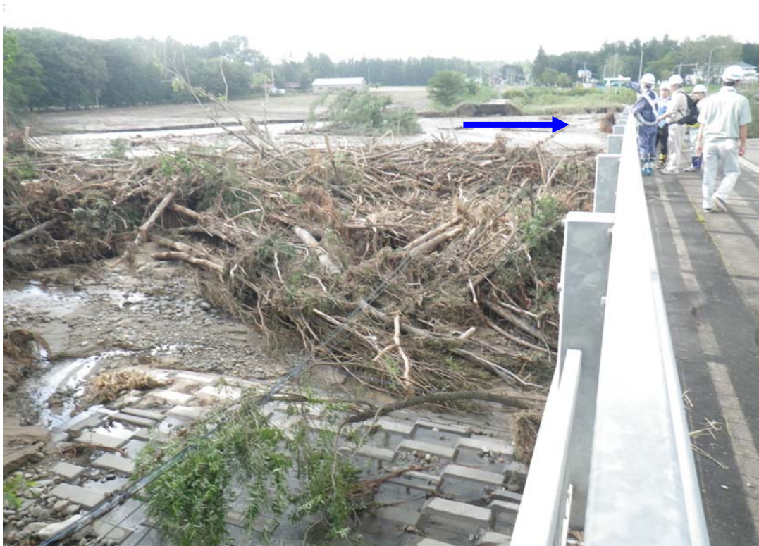
写真-3.4.4 橋梁上流側の流木堆積状況
