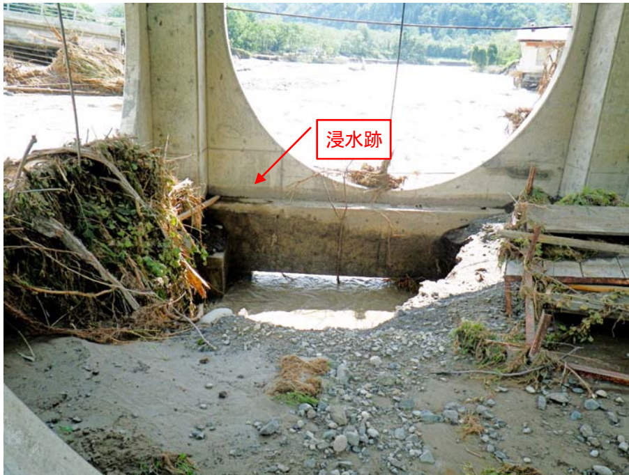
写真-3.3.5 右岸側上流側の千栄神社基礎洗掘状況
