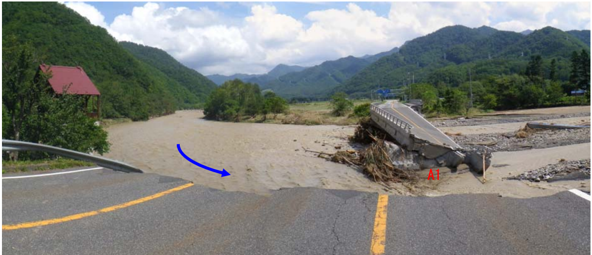
写真-3.3.3 右岸側より撮影
