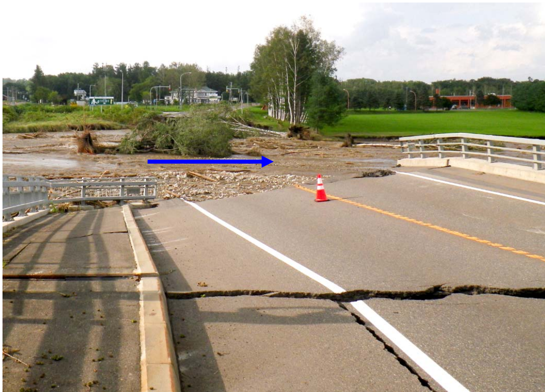
写真-3.4.2 A1 橋台背面土流失状況
