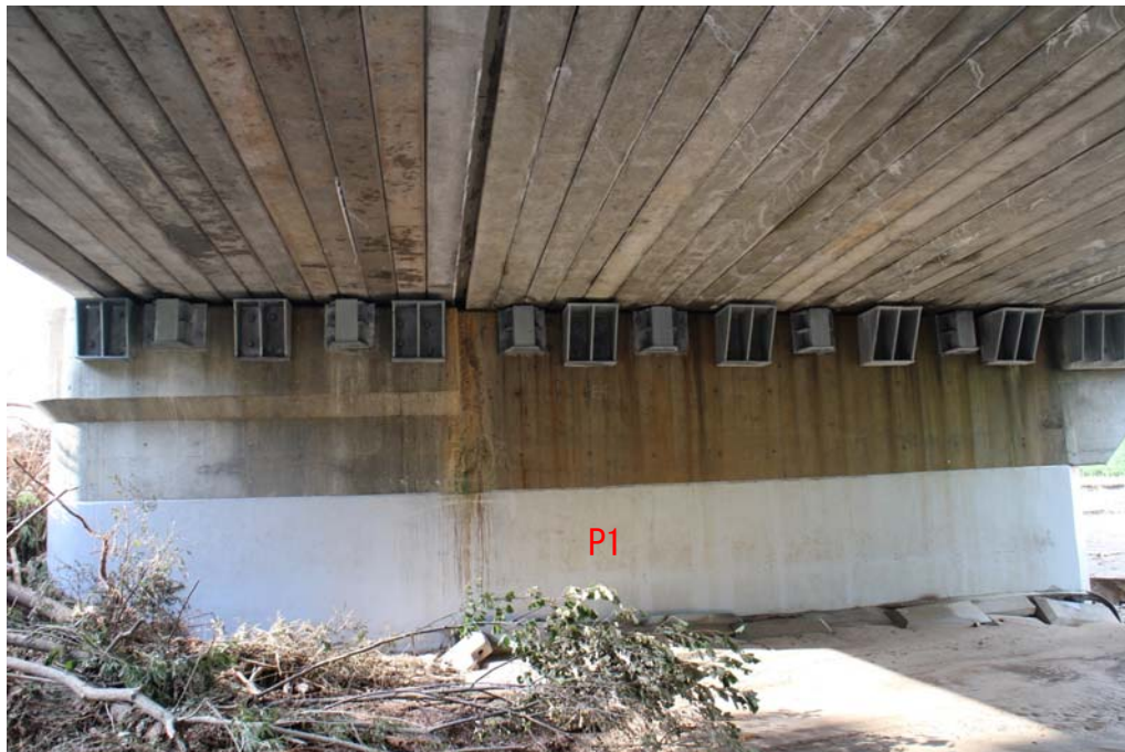
写真-3.4.7 P1橋脚の状況（P2側から撮影）
