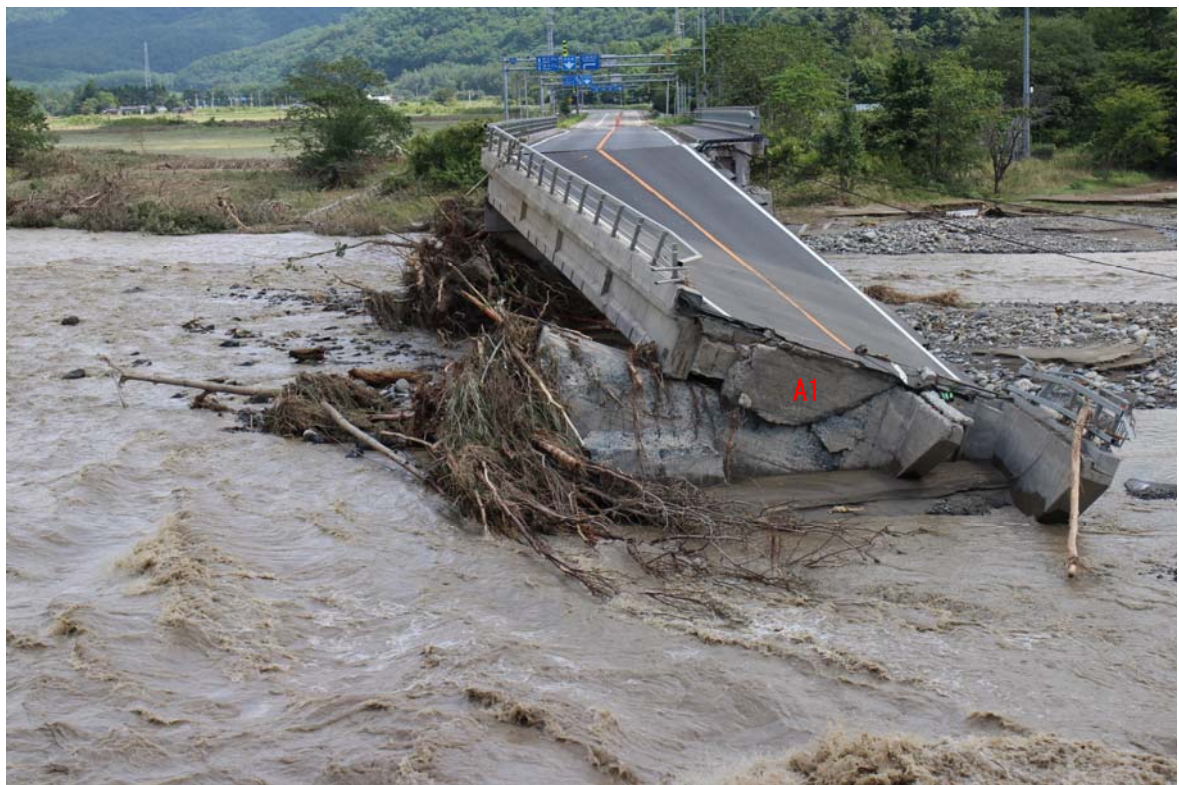
写真-3.3.4 右岸側より撮影
