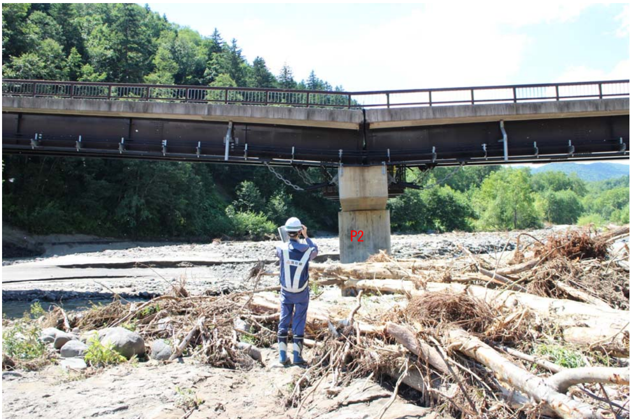
写真-3.1.2 P2 橋脚の状況（下流側から撮影）
