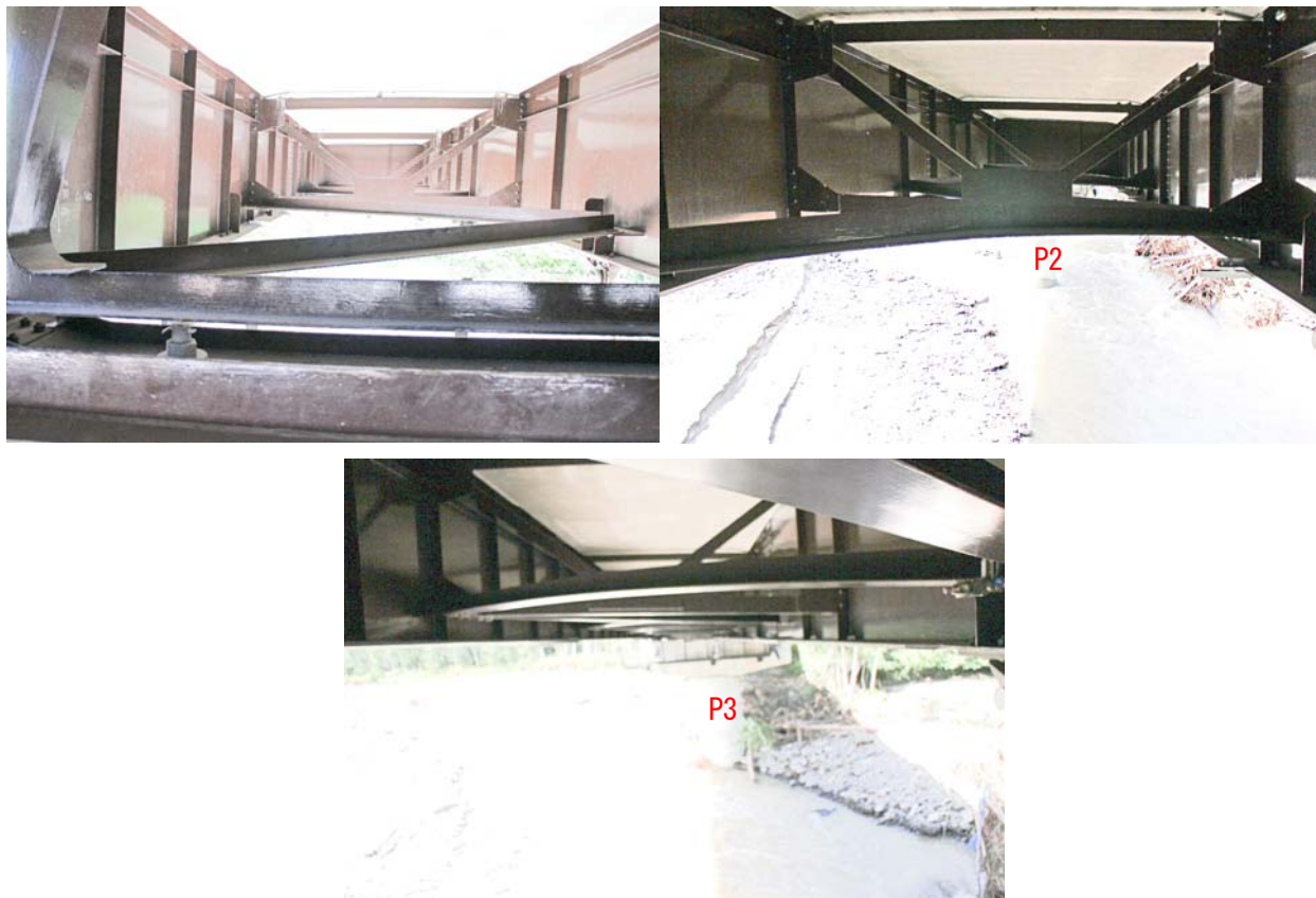
写真-3.1.12 第1径間の状況（写真左上）（P1 橋脚上より撮影）、 第2径間の状況（写真右上）（P1 橋脚上より撮影）、及び第3径間の状況（写真下）（P2 橋脚上より撮影）
