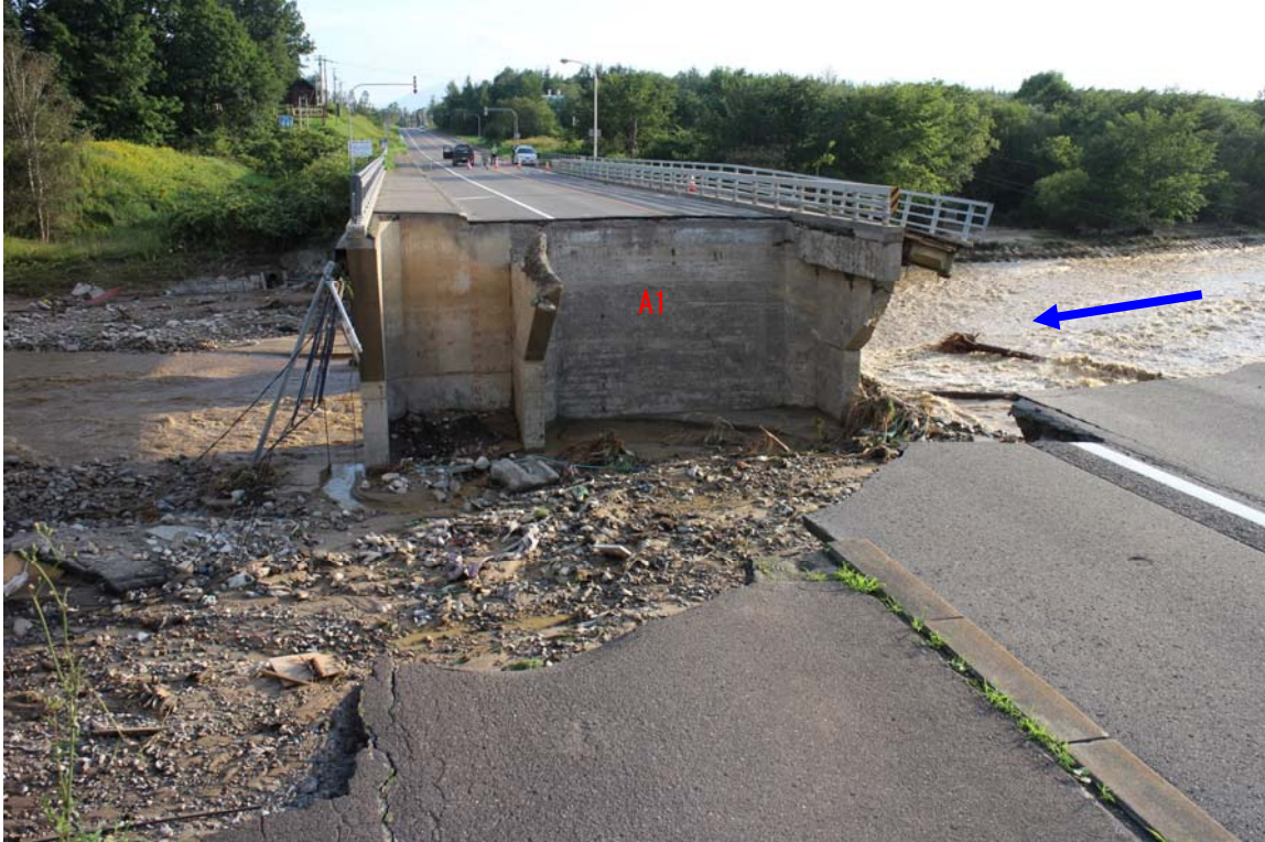
写真-3.5.2 A1 橋台状況（左岸側より撮影）
