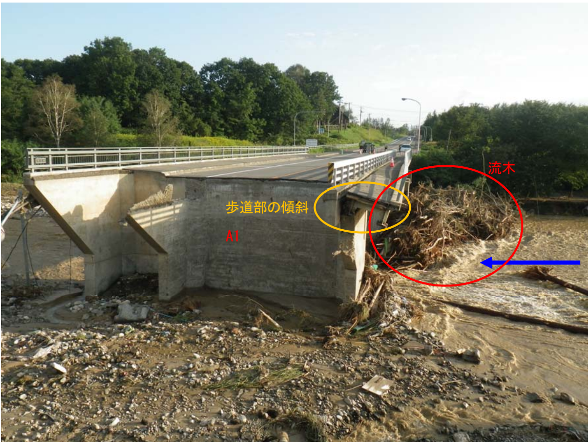
写真-3.5.3 A1 橋台状況（左岸側より撮影）
