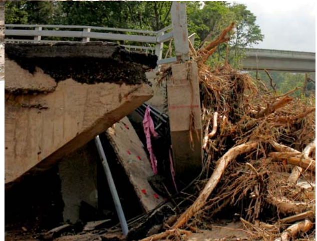
写真-3.4.3 A1 橋台傾斜沈下状況
