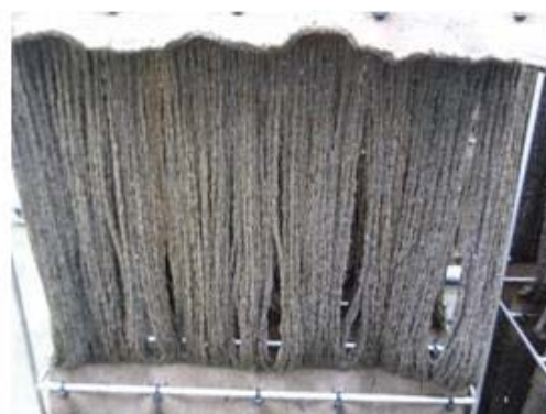
図2-6 特殊繊維担体の汚泥付着状況
