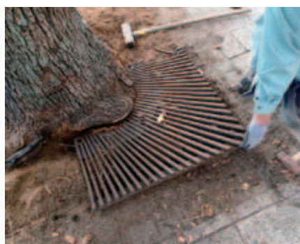
（踏圧防止板の支障部の撤去）
