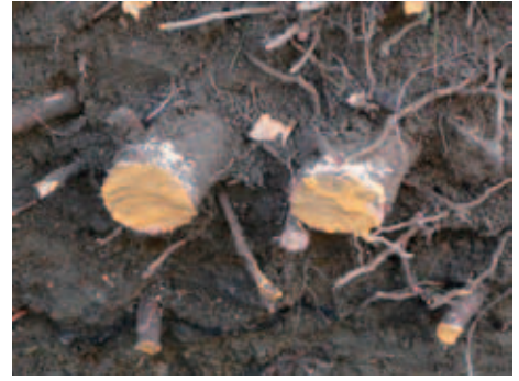
写真 -3.16 周辺工事で切断された根系の適正な処置（鋭利な刃物による切断と殺菌剤塗布）
