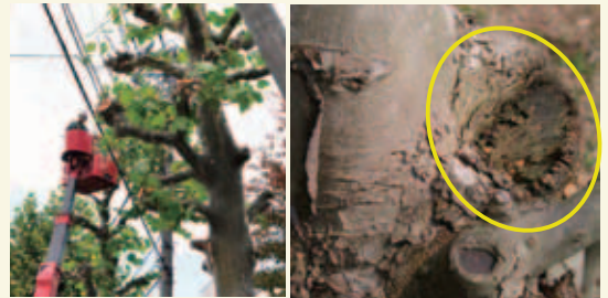
樹体の上から見ることで確認できる異状
