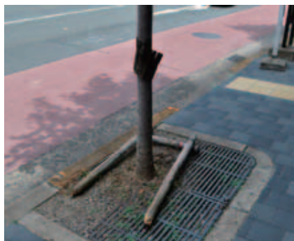
（支柱材の折損）
