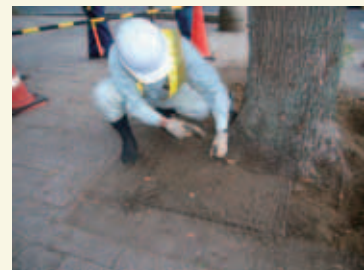
食い込んだ踏圧防止板の撤去
