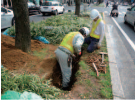
写真 -3.16 周辺工事で切断された根系の適正な処置（鋭利な刃物による切断と殺菌剤塗布）
