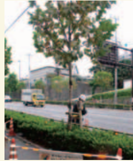
支柱の補修作業
