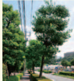
被害が発生しそうな傾斜木
