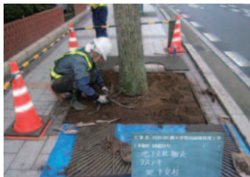
写真-3.7 地下支柱の撤去
