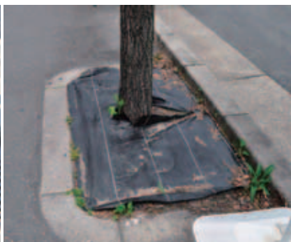
（マルチング材の劣化）
