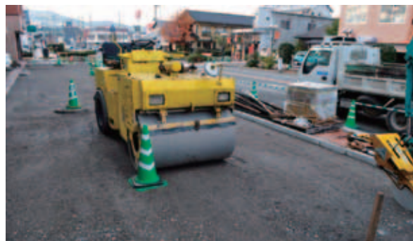
写真-3.15 周辺工事による土壌踏圧
