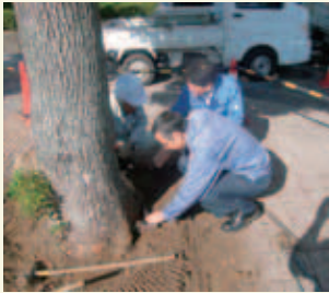
地下支柱の状態確認
