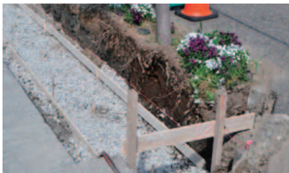
写真-3.14 周辺工事による根系損傷
