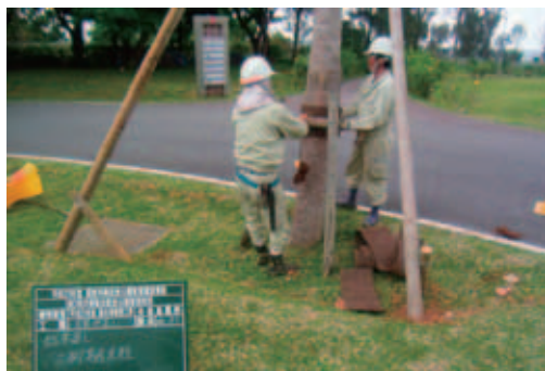
写真-3.8 支柱の再設置
