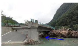
橋梁による流木の捕捉 (小本川、H28台風10号)
