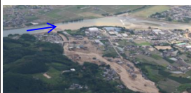
土砂堆積による被害 (赤谷川、H29九州北部豪雨)
