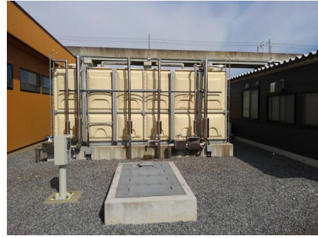
写真-4 井戸設備
