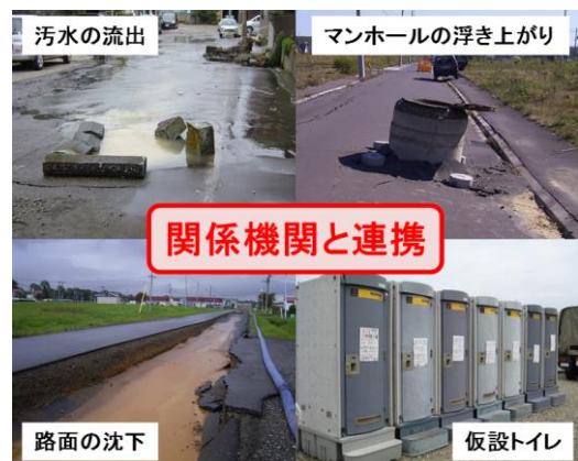
図-1 下水道施設被災時の例
