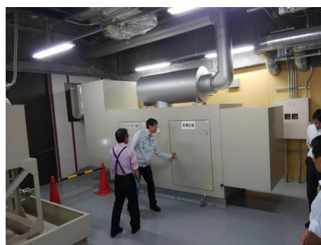
写真-2 自家発電装置
