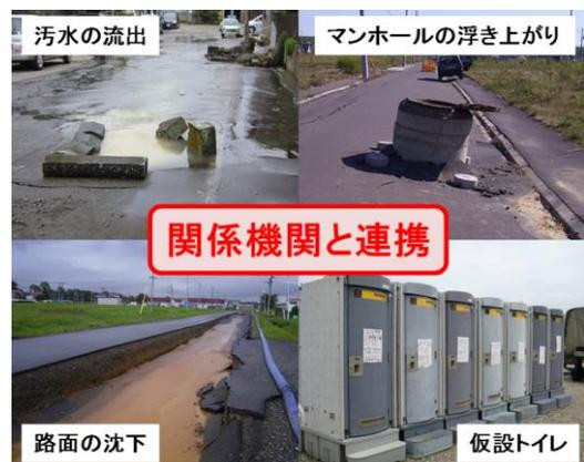
図-1 下水道施設被災時の例
