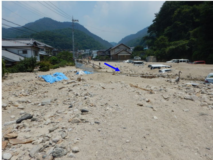
写真 1.1 土砂・洪水氾濫による被害状況（平成 30 年 7 月豪雨 広島県呉市）
