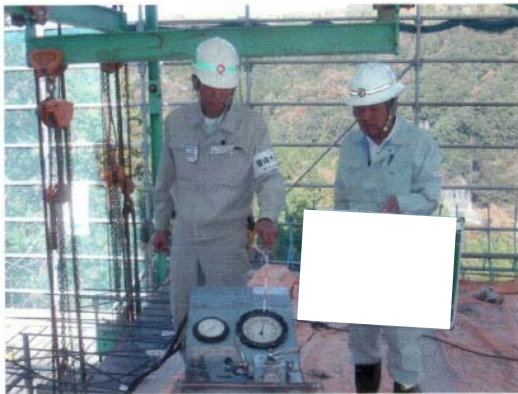
参写真-1.4.4 主ケーブル緊張検査状況
