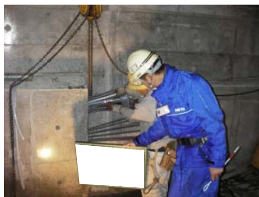
参写真-1.2.7 適切なプレストレスカの確保（PC 鋼材配置確認、緊張管理）
