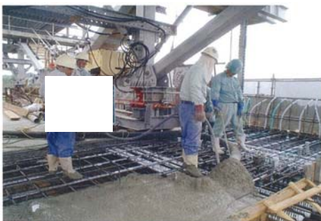
参写真-1.3.2 打設管理状況
