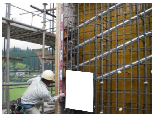
参写真-1.2.7 適切なプレストレスカの確保（PC 鋼材配置確認、緊張管理）
