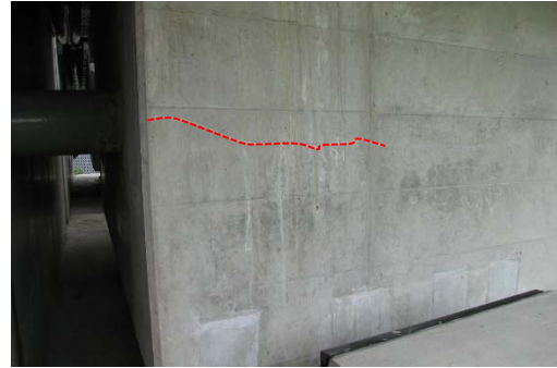
参写真-1.2.3 桁端部のひび割れ (写-2)
