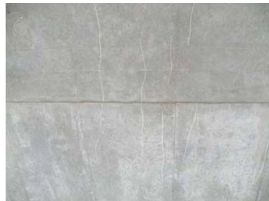
参写真-1.1.3 下床版橋軸方向ひび割れ 3 (写真番号 22)
