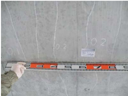
参写真-1.1.1 下床版橋軸方向ひび割れ (写真番号 20)
