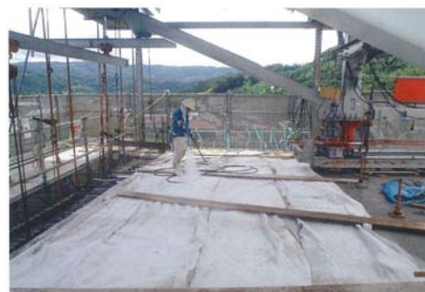
参写真-1.3.3 養生管理状況
