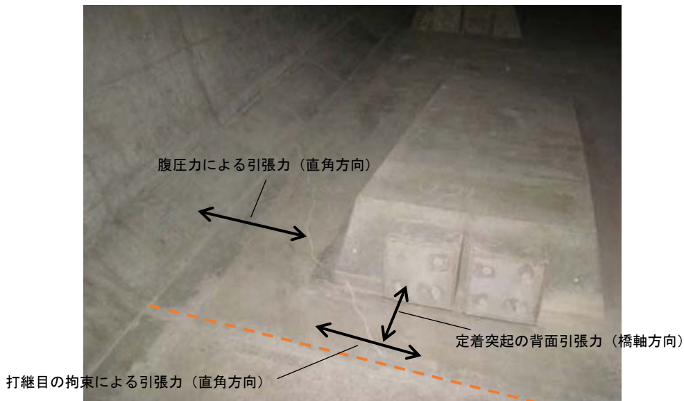
参写真-1.1.8 下床版定着突起近傍のひび割れ (写真番号 24)
