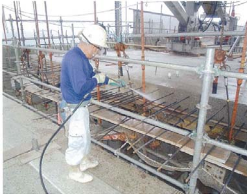
参写真-1.3.4 打継ぎ処理状況
