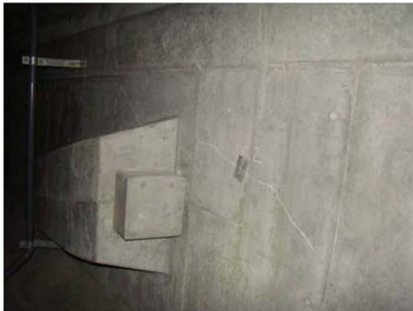
参写真-1.1.4 ウェブ付根近傍のひび割れ (写真番号 25)
