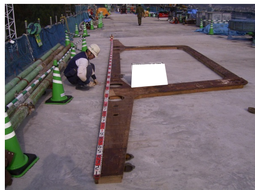
参写真-1.4.1 棲枠検査状況
