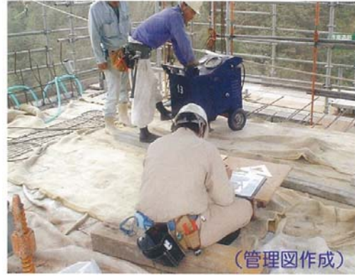
参写真-1.3.5 緊張管理状況
