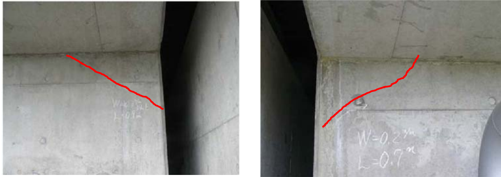
写真-3.6.1 桁端部のひび割れ事例
