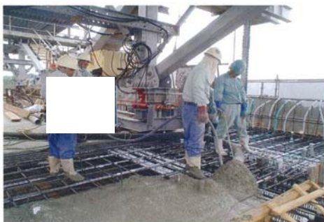
参写真-1.3.2 打設管理状況
