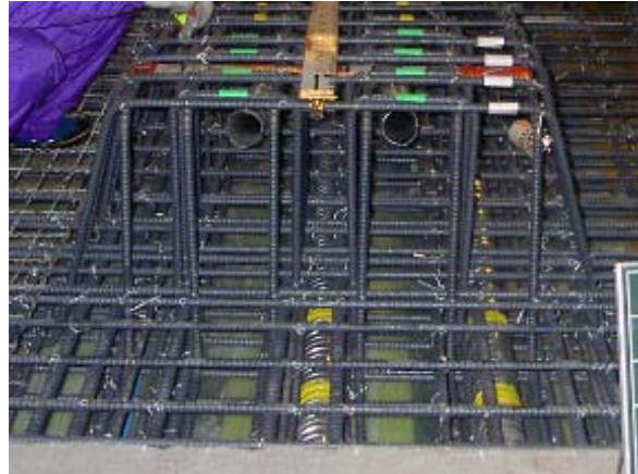
参写真-1.1.10 下床版定着配筋写真（拡大）
