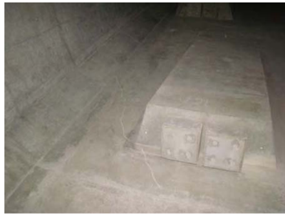
参写真-1.1.5 下床版定着突起近傍のひび割れ (写真番号 24)
