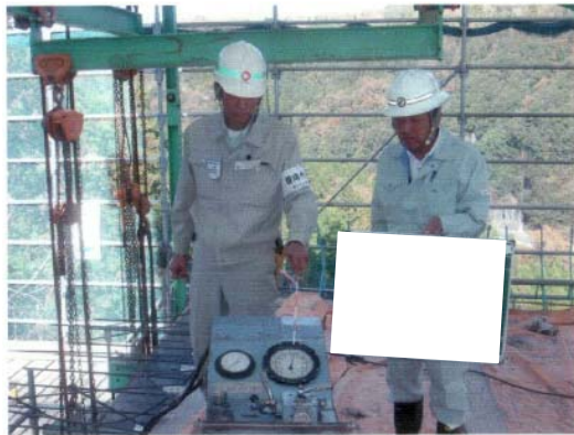
参写真-1.4.4 主ケーブル緊張検査状況
