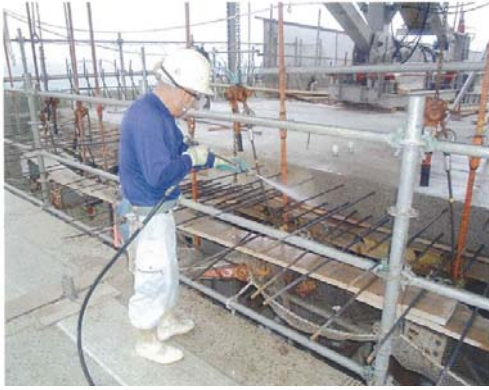
参写真-1.3.4 打継ぎ処理状況
