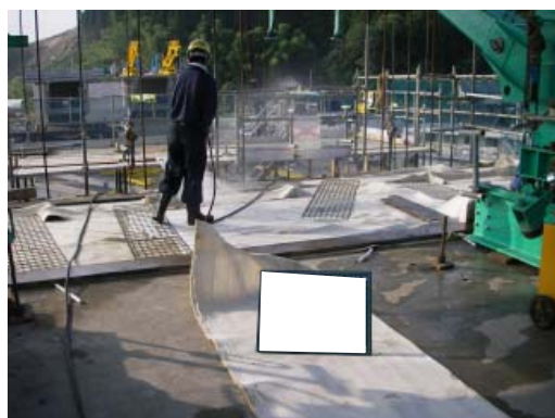
参写真-1.2.8 コンクリートの品質確保（湿布養生、冬季の給熱養生）
