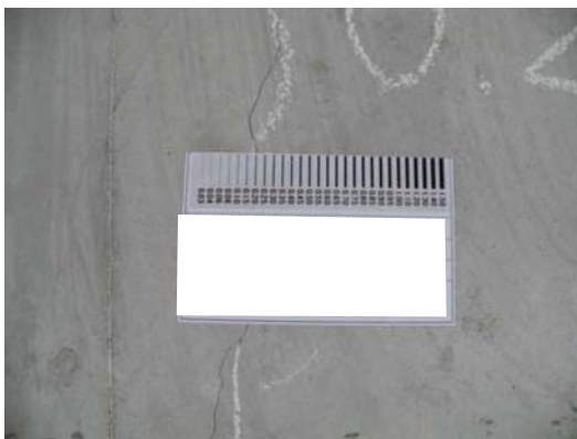
参写真-1.1.2 下床版橋軸方向ひび割れ (写真番号 21)
