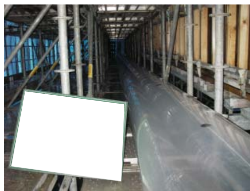
参写真-1.2.8 コンクリートの品質確保（湿布養生、冬季の給熱養生）
