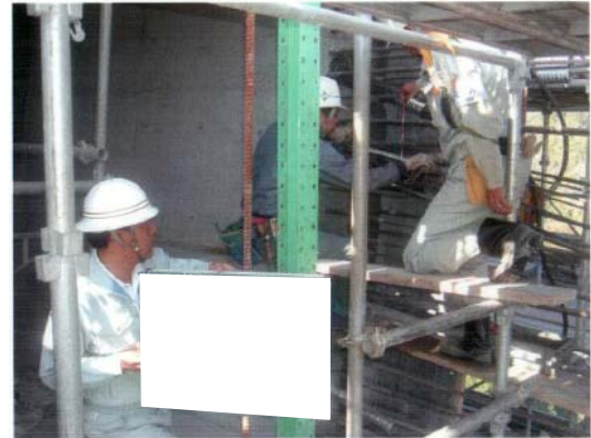
参写真-1.4.4 主ケーブル緊張検査状況
