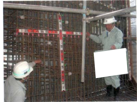
参写真-1.4.3 下床版ウェブ配筋検査状況
