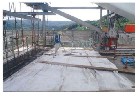
参写真-1.3.3 養生管理状況
