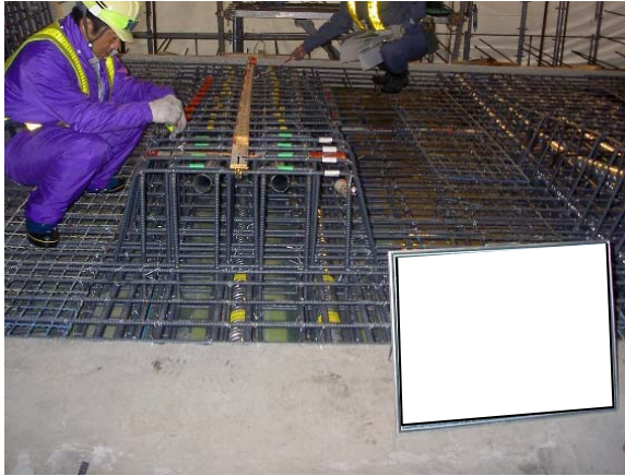
参写真-1.1.9 下床版定着配筋写真
