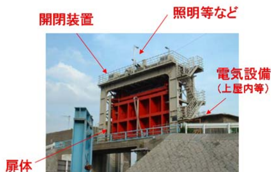
図 3-1 水門の構成部材の例
