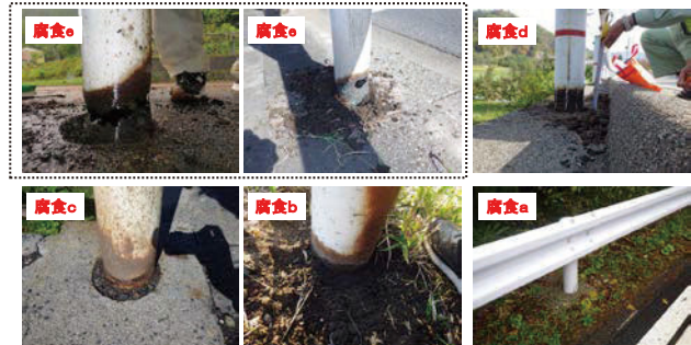
腐食e: 部材に穴があき腐食が生じた状態 腐食d: 層状さびが生じ、大きな板厚減少がある状態(穴があくまでに至っていない状態) 腐食c: 層状さびが生じ、明らかな板厚減少がある状態 腐食b: 防食機能の劣化が進行し、腐食が生じつつあるが板厚減少は僅かである状態 腐食a: 健全な状態(防食機能の劣化に留まる状態を含む)
