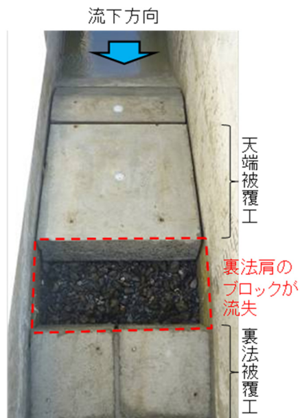
写真-2.2.5.1 水理模型実験で見られた裏法肩のコンクリートの流失
