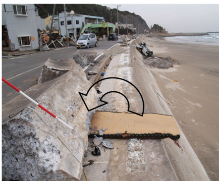
写真-2.2.2.1 波返工の破損事例 (福島県豊間海岸)
