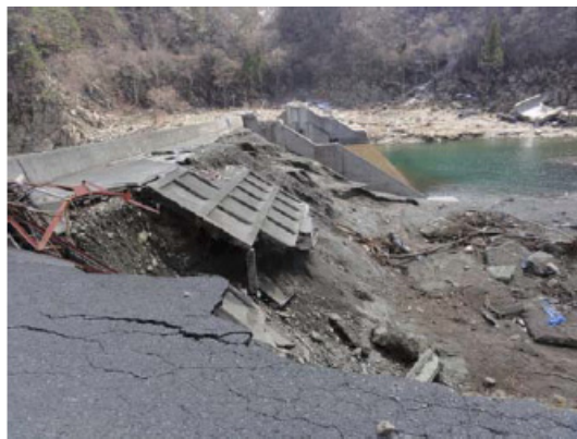
写真-2.2.3.2 裏法尻洗掘から根留工が流失し半壊した堤防（岩手県接待海岸）
