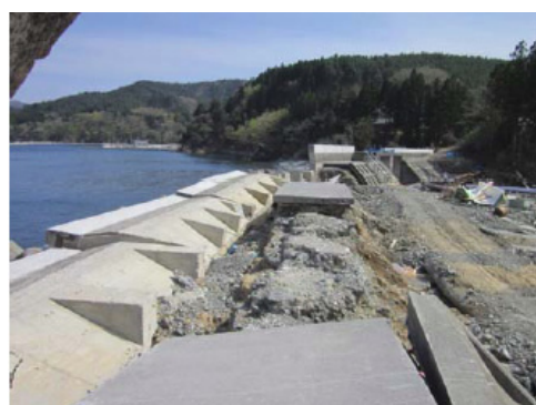
写真-2.2.2.2 表法被覆工と一体化した 波返工の破損事例 (岩手県下甫嶺海岸)
