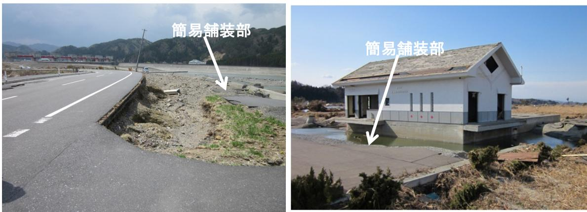
写真-3.2.4 簡易舗装の損傷事例
