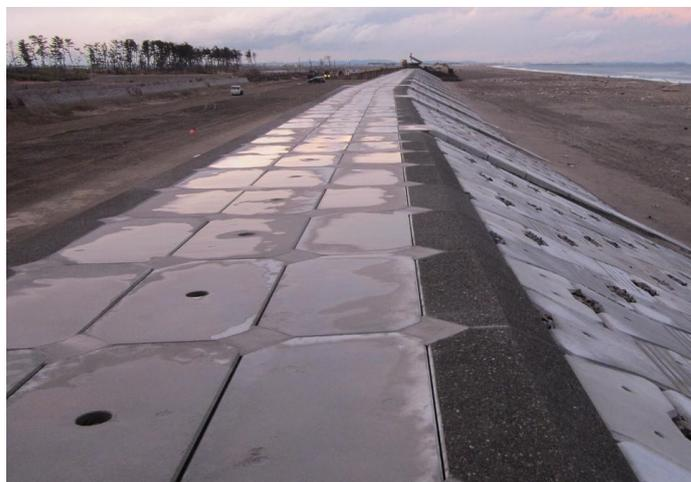
写真-3.4.1 天端被覆工に設けられた点検穴兼空気抜き穴（仙台湾南部海岸）
