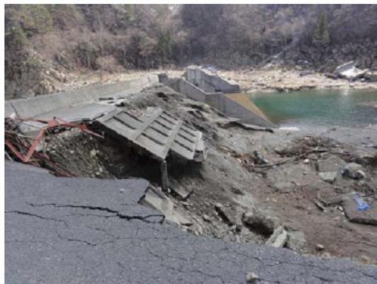
写真-2.2.3.2 裏法尻洗掘から根留工が流失し半壊した堤防（岩手県接待海岸）
