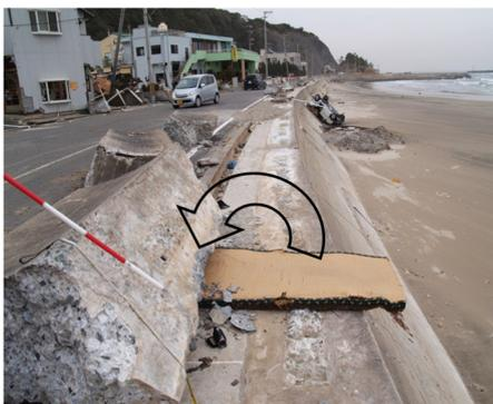
写真-2.2.2.1 波返工の破損事例
