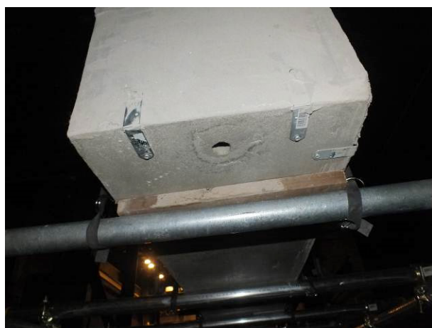
進入口：水抜き孔（ \phi 25mm）
