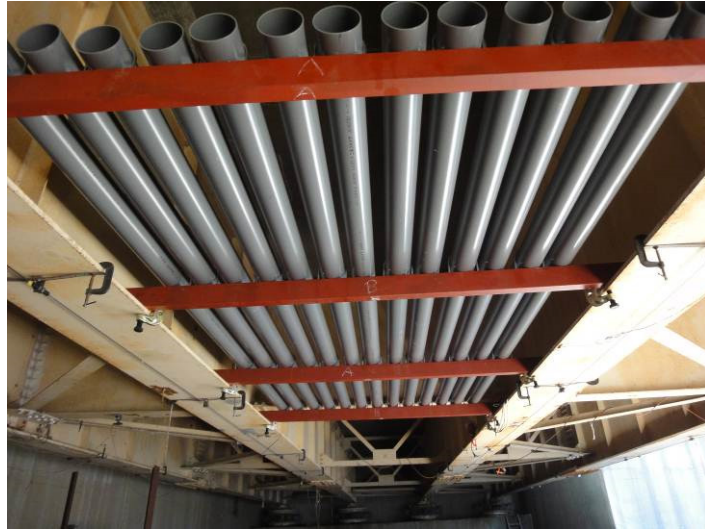
▲Case1 供試体の設置状況
