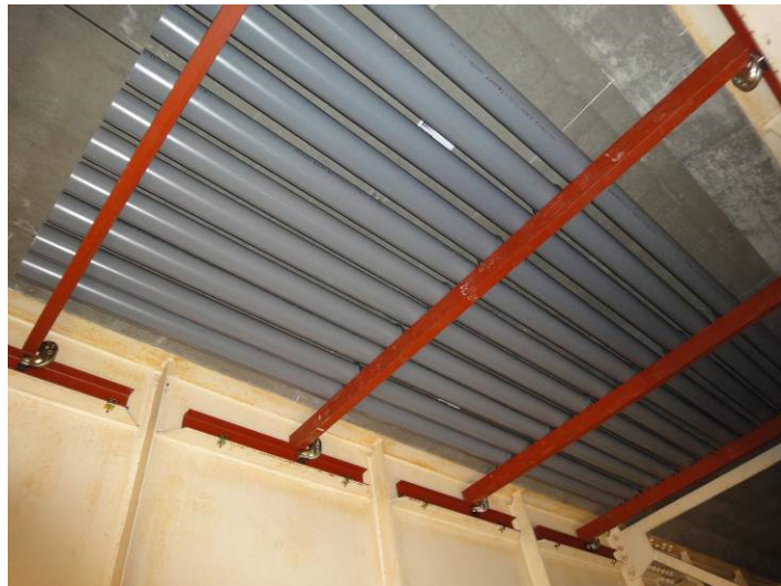
▲Case2 供試体の設置状況
