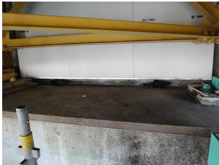
▲Case3 供試体の設置状況
