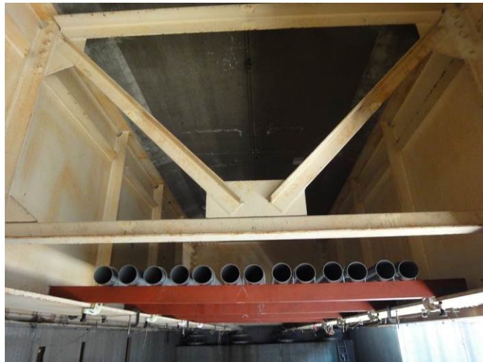
▲Case1 供試体の設置状況
