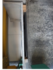
▲ Case3：狭い支承部
