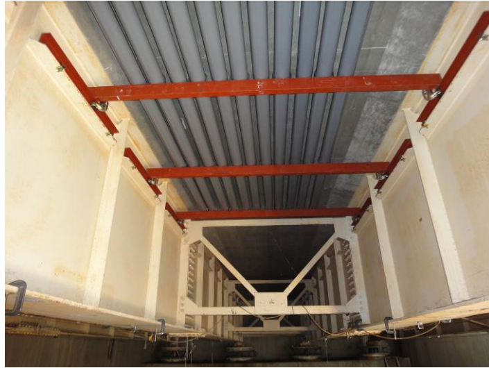
▲Case2 供試体の設置状況
