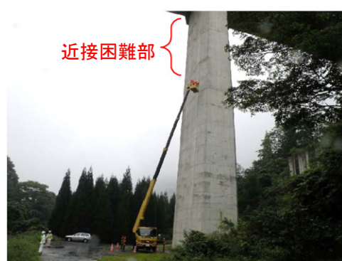
写真 2.1.1 近接目視点検困難箇所の代表事例
