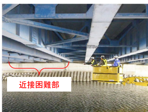
写真 2.1.1 近接目視点検困難箇所の代表事例
