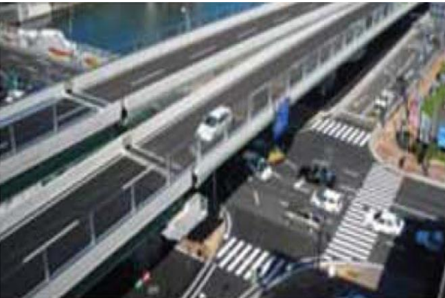
▲梁川橋東交差点（松山町－茂里町工区）
