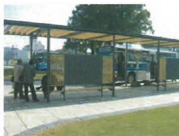
▲完成したシェルター
