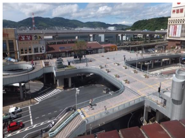
▲黒崎駅ペDESTリアンデッキ ※北九州市提供
