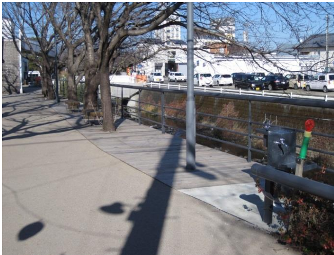
▲歩道舗装・ウッドデッキ
