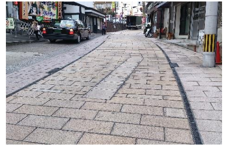
▲石張り舗装、温泉管共同ボックス
