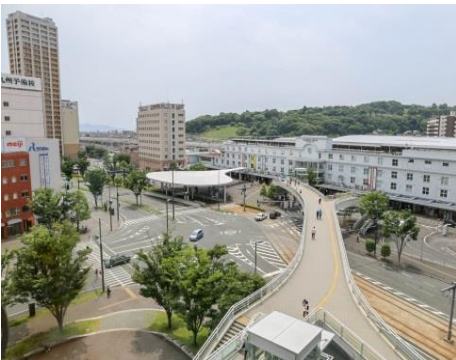
▲交流広場、東口駅前広場全景
