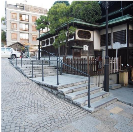
▲スロープによる歩道の段差解消
