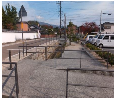
▲水路改修（国分寺地区）
