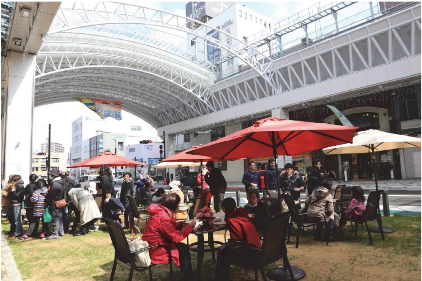
空間再配分により百貨店前の歩道を拡幅するとともに、全天候対応型の屋根付き広場として整備 鳥取駅前太平線（鳥取県・鳥取市）
