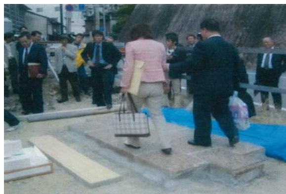
▲石張り舗装の試験施工
