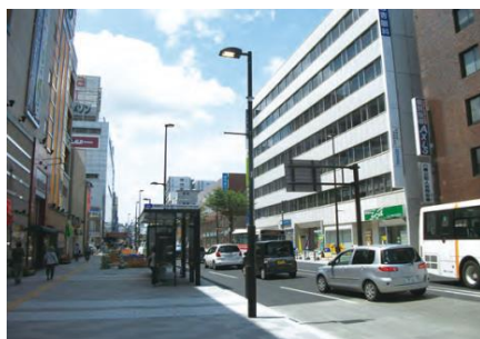
▲道路照明 ※北九州市提供
