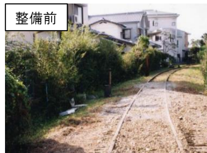
▲引込み線廃線区間
