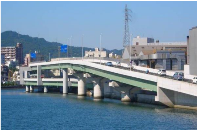
▲浦上川高架橋（幸町工区） ※長崎県提供
