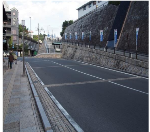
▲付替え道路（横断方向にスピードハンプの設置）
