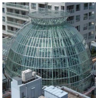
▲ドームおよび上空通路
