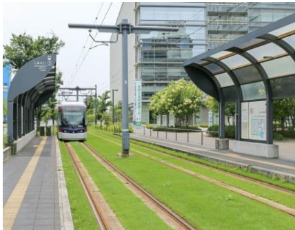
▲サイドリザベーション、軌道敷緑化
