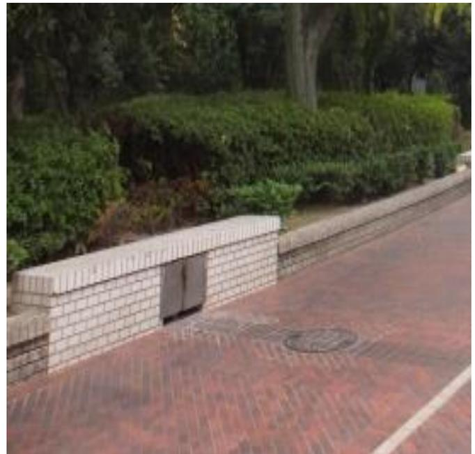
▲屋台への水道・電気・下水道設備ユニットを収納したベンチ
