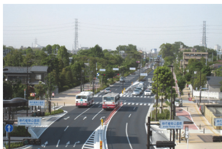
住宅地の環境に配慮した現道拡幅による整備 33: 調布保谷線（三鷹市・調布市）
