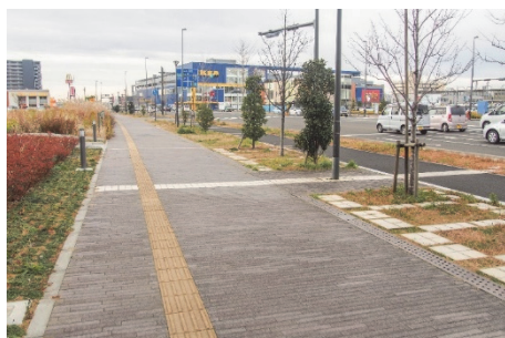
新市街地の主要動線となる幹線道路の整備 11: あすと長町大通り線（仙台市）
