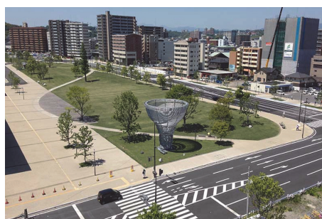
防災拠点・広場としての機能を備えた道路整備 94：大分いこいの道（大分市）
