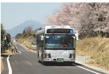
廃線した鉄道の軌道敷を BRT 専用道に転用 19：鹿島鉄道跡地バス専用道（石岡市・小美玉市）
