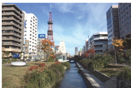
地上部に親水空間、地下にアンダーパスを整備 1：創成川通（札幌市）
