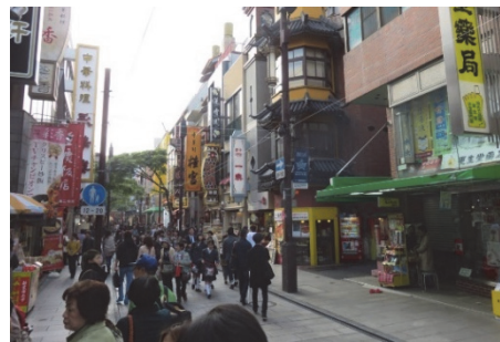
柱状トランスを用いた電線類の地中化 35：横浜中華街大通り（横浜市）
