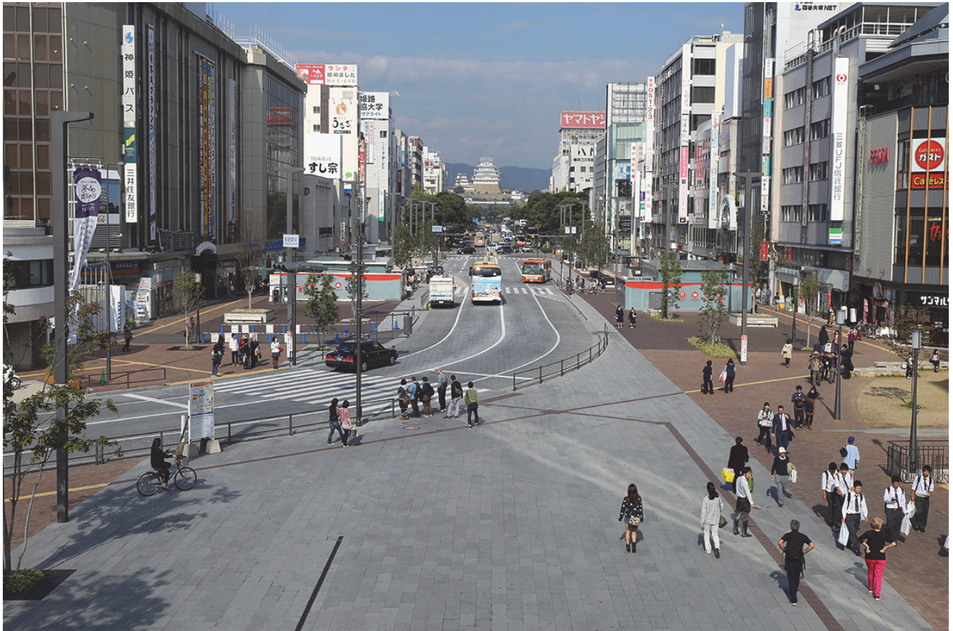
駅前広場と一体となったシンボルロードの整備にあたり、幅員再構成による公共交通と歩行者中心のトランジットモールを実現 大手前通り（兵庫県・姫路市）
