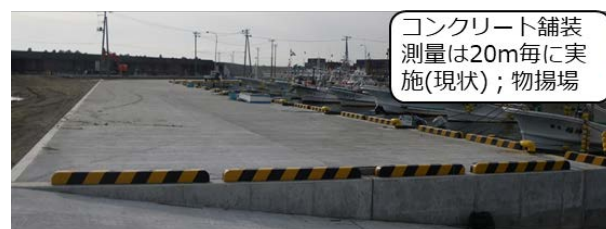
図-4.35 舗装コンクリート（筆者撮影，2014 年）
