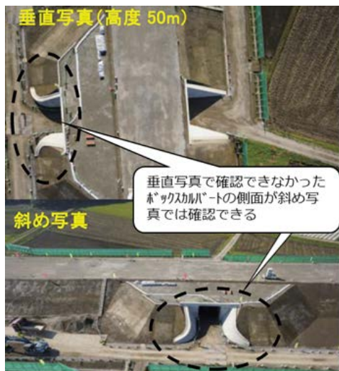
図-4.40 空撮写真例（土工） 62)
