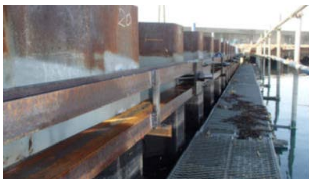
図-4.28 腹起 (筆者担当工事で撮影, 2014 年)
