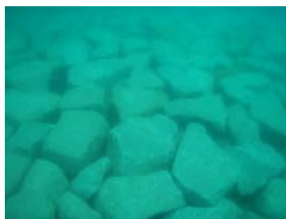
図-4.20 捨石均し面（筆者担当工事で撮影，2009 年）
