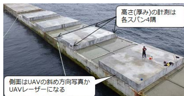
図-4.34 上部コンクリート（筆者撮影，2016 年）
