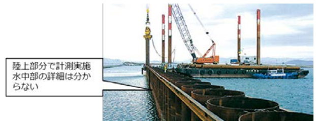
図-4.26 鋼管矢板打設状況 53)
