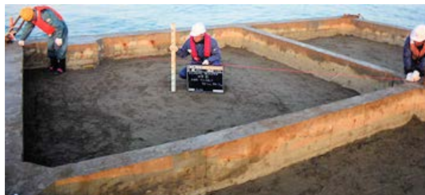
図-4.25 中詰出来形計測状況（筆者撮影，2013 年）
