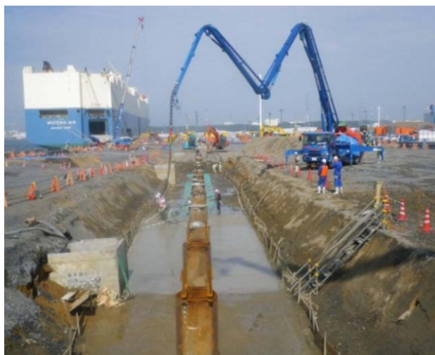
写真7.10 クレーン基礎杭部の復旧 (提供：港湾空港総合技術センター)
