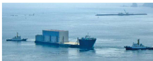
写真7.3 防波堤ケーソン曳航 (提供：日本埋立浚渫協会)
