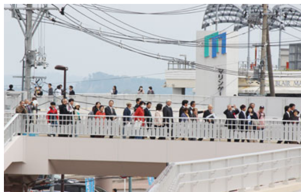
写真9.2 津波避難デッキ（出典：塩釜市HP）
