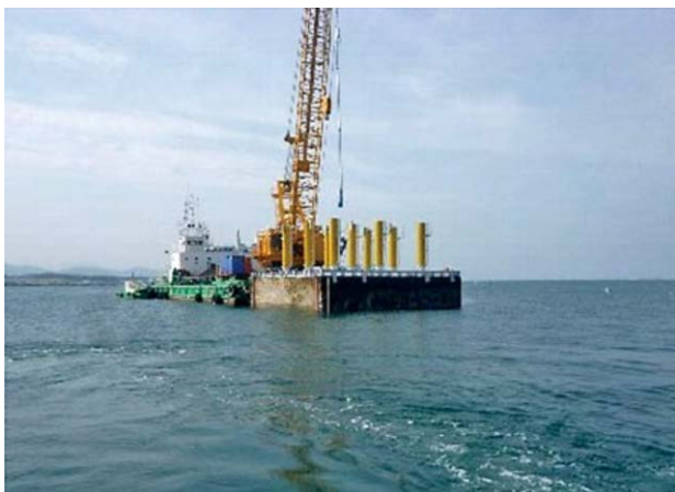
写真7.7 相馬港での復旧工事（ケーソン曳航） （提供：日本埋立浚渫協会）
