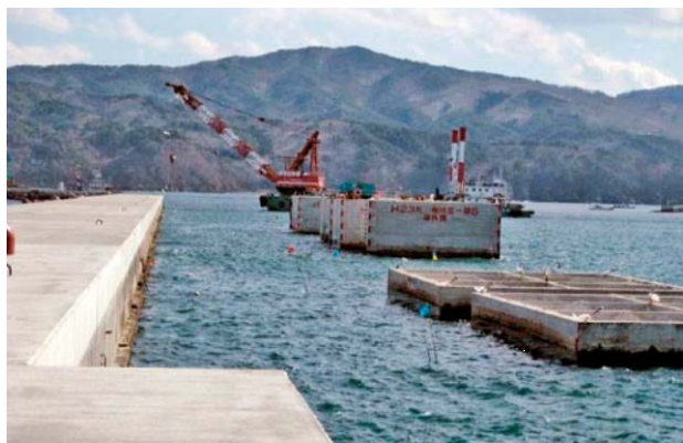
写真7.2 宮古港の復旧工事の様子 (提供：日本埋立浚渫協会)
