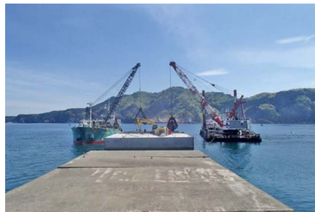
写真7.4 ケーソン中詰め投入状況 (提供：日本埋立浚渫協会)
