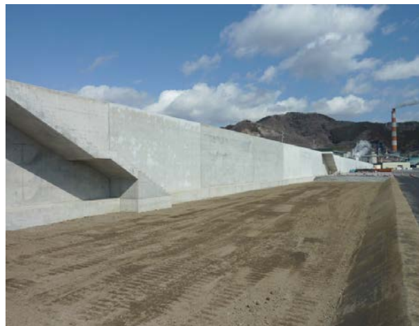
写真8.3 大船渡港防潮堤の整備状況 (平成28年2月著者撮影)
