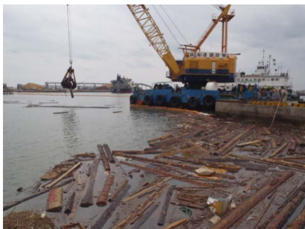
写真7.5 木材の散乱した石巻港区 (提供：東北地方整備局)
