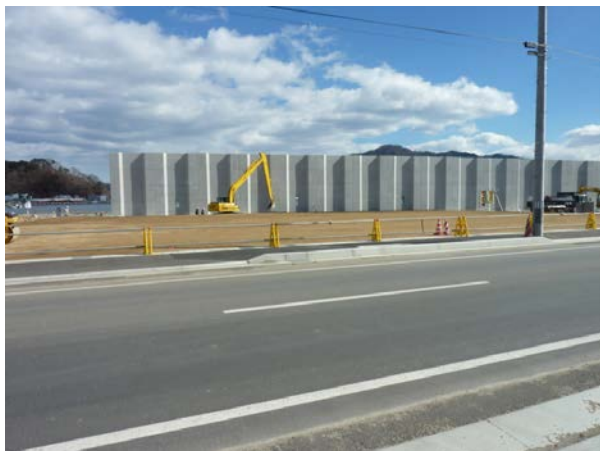
写真8.1 宮古港鉾ヶ崎地区防潮堤整備状況 (平成28年2月著者撮影)
