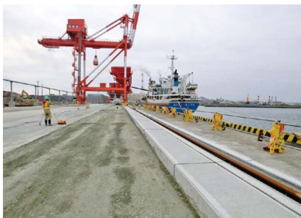
写真7.8 小名浜港での復旧工事 (提供：日本埋立浚渫協会)
