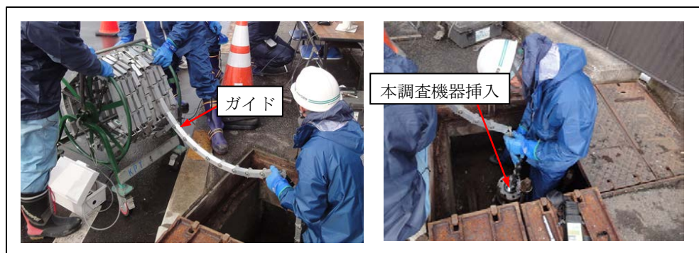
写真 3. 2-2 視覚調査の状況
