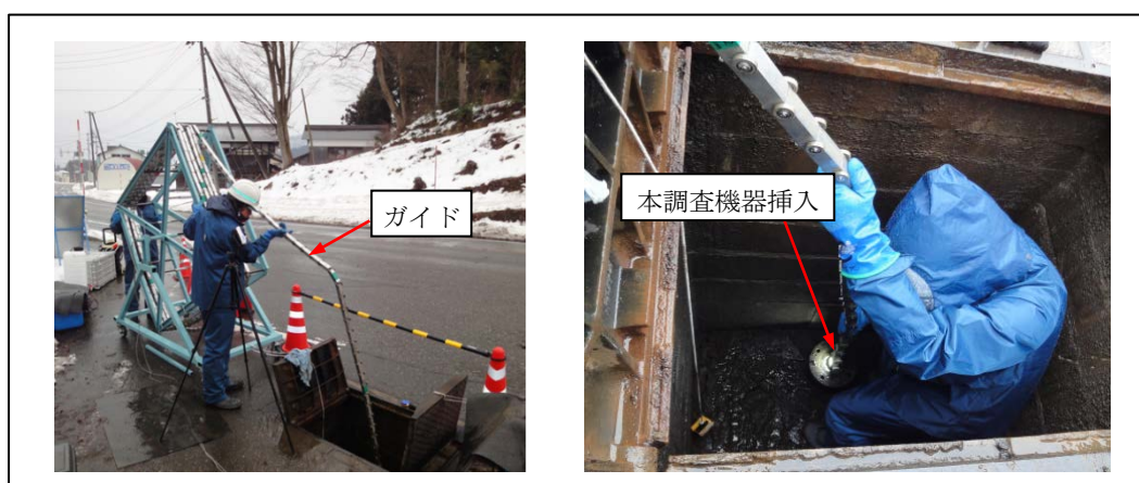
写真 3.1-2 視覚調査の状況
