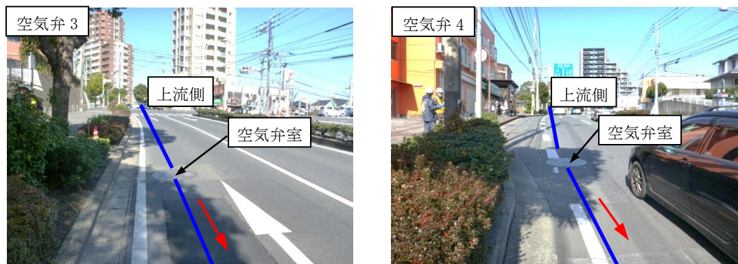
写真 3.5-1 空気弁 3 及び空気弁 4 の周辺の状況
