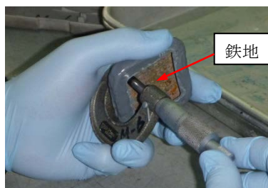
写真 2-2 管厚測定の様子
